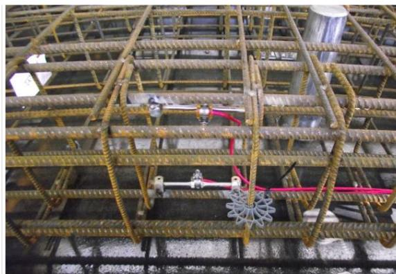
Fig. 13 – Estensimetri saldati all'armatura e installazione all'intradosso del concio
