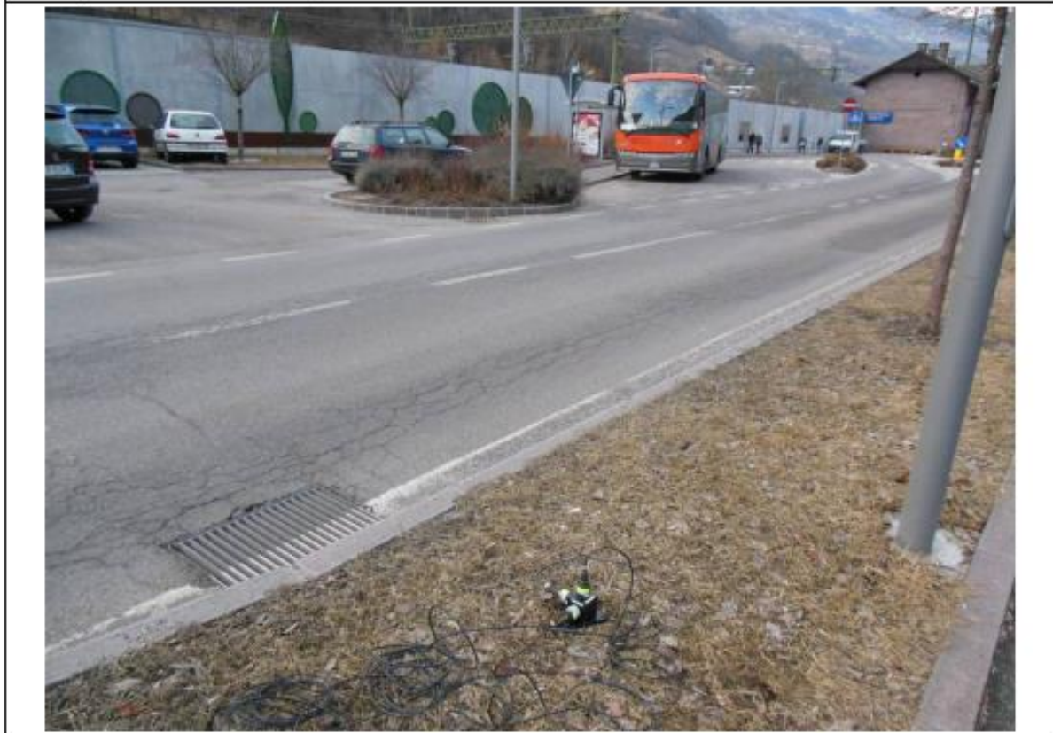
Fig. 10 - Installazione della postazione S2_P4
