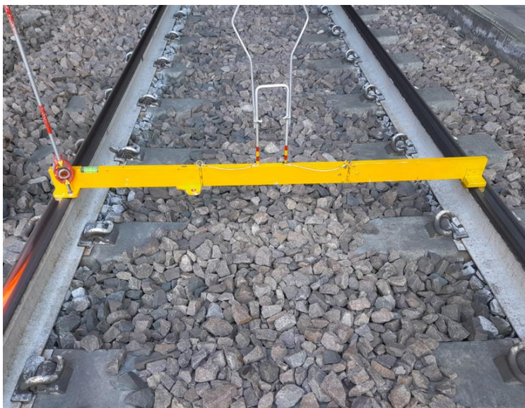
Fig.24 – Rilievo Binari Stazione Ponte Gardena
