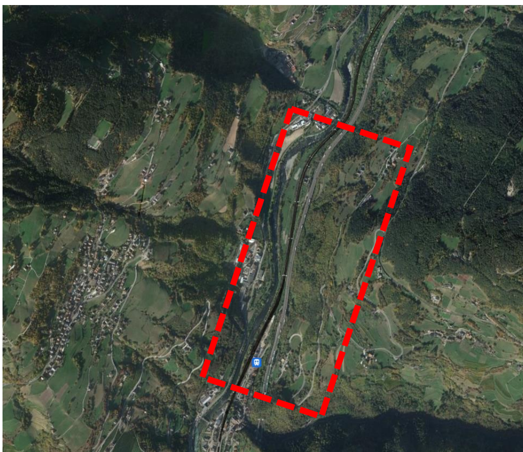
Figura 1 – Vista aerea della zona dell'intervento
