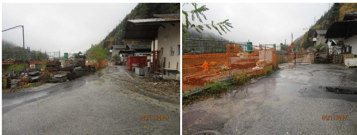
Fig. 26 – Direzione preferenziale verso il cantiere operativo C.O.01A – Lato nord-ovest cantiere operativo.
