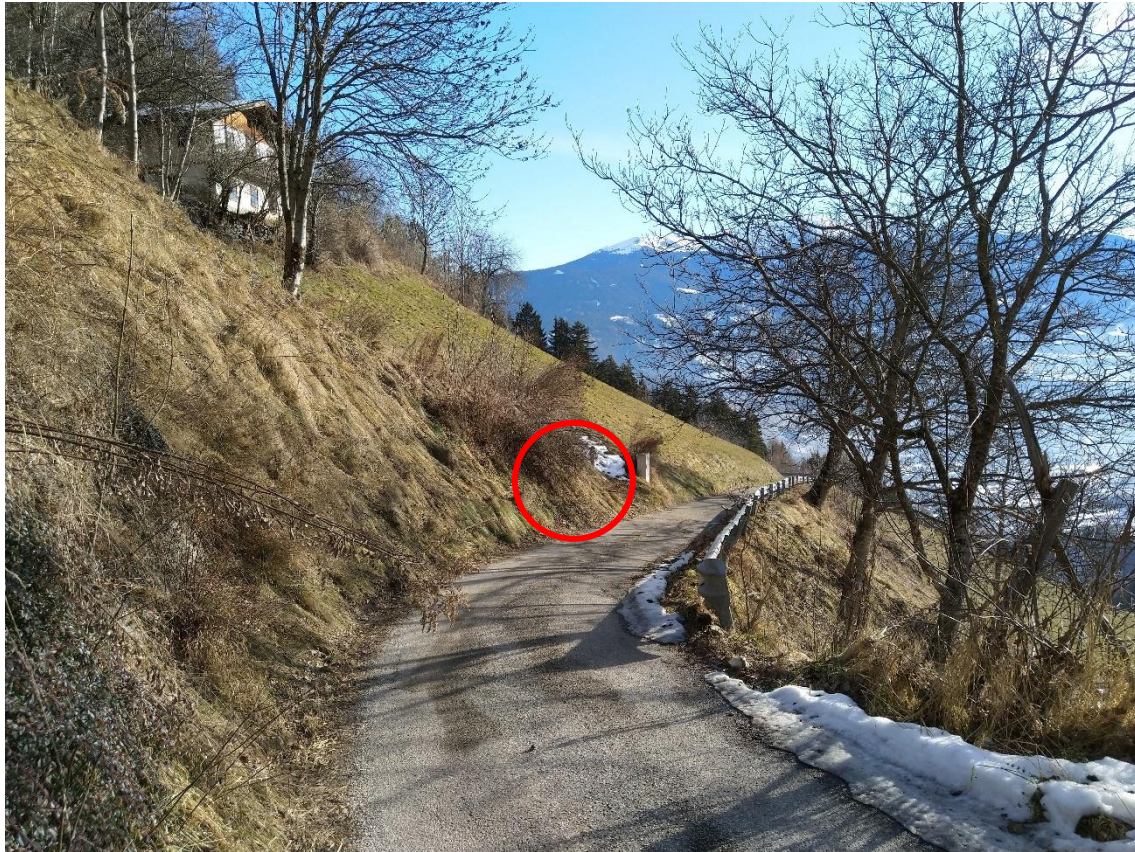
Fig. 30 – Localizzazione del luogo di realizzazione della vasca di disconnessione in progetto, sorgenti S13 e S14
