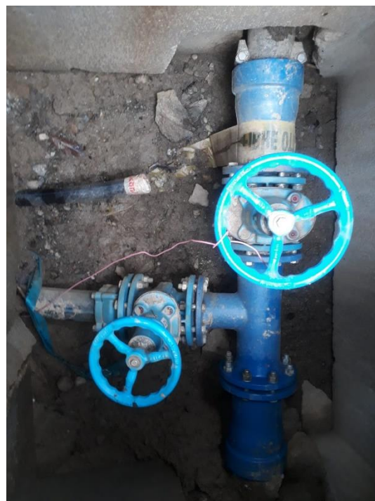
Fig. 14 – Pozzetto di raccordo esistente a valle di Maso Tenner e relativo arredo idraulico, sorgente S5A
