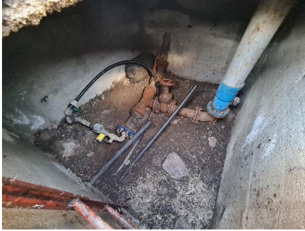
Fig. 18 – Pozzetto di raccordo esistente e punto di realizzazione del collegamento, sorgente S7A
