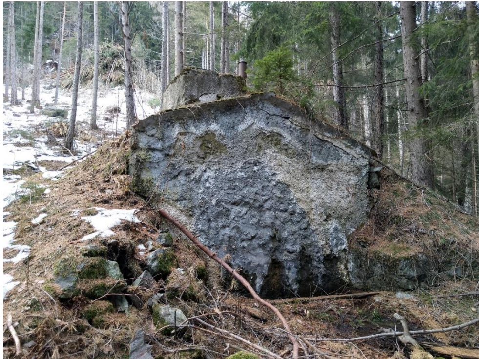
Fig. 26 – Serbatoio esistente a monte utenza servita da sorgente S12
