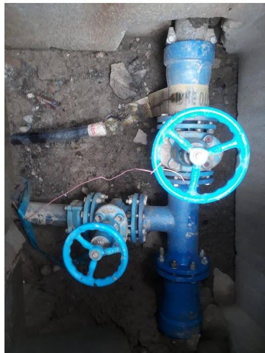
Fig. 8 – Pozzetto di raccordo esistente a valle di Maso Tenner e relativo arredo idraulico, sorgente S5A
