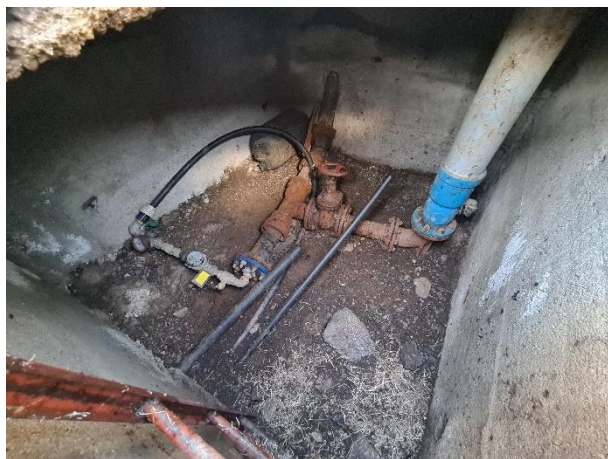
Fig. 15 – Pozzetto di raccordo esistente e punto di realizzazione del collegamento, sorgente S7A
