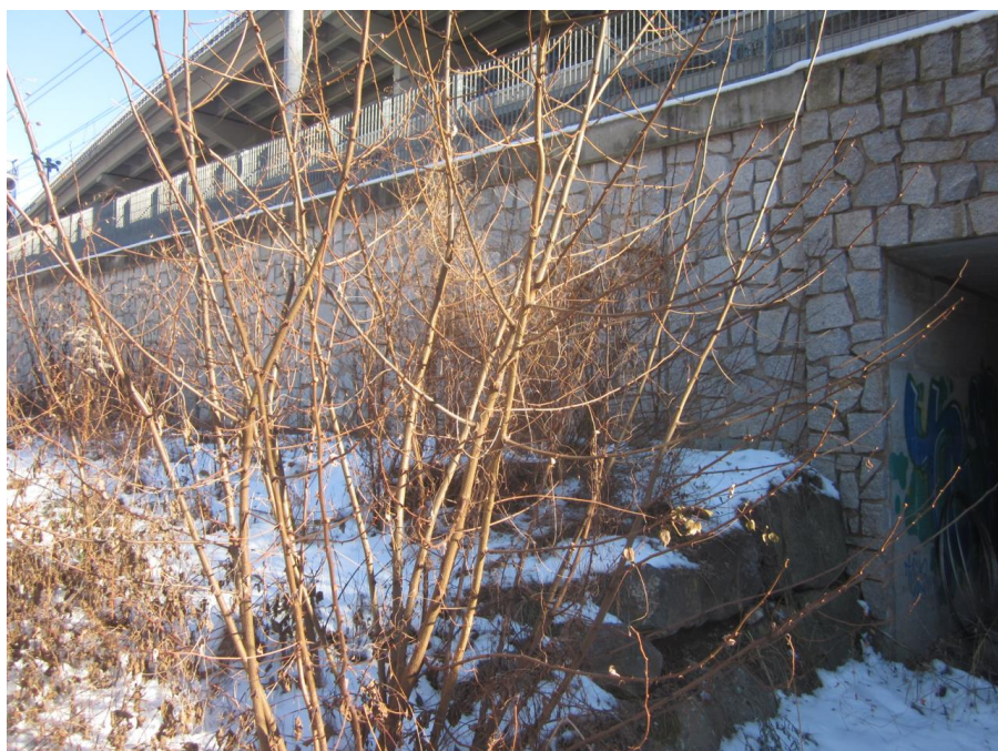
Fig. 8 – Immagine da sopralluogo – vista da valle n.3
