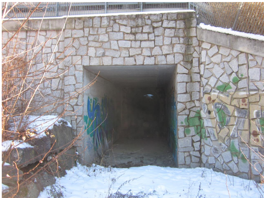
Fig. 7 – Immagine da sopralluogo – vista da valle n.2
