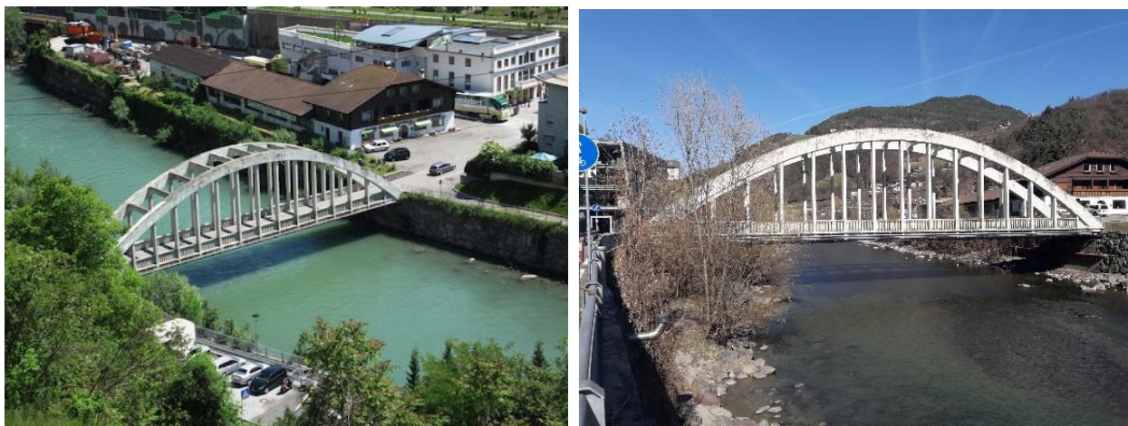
Fig. 3 – Il ponte lungo via Isarco a Ponte Gardena (BZ).
