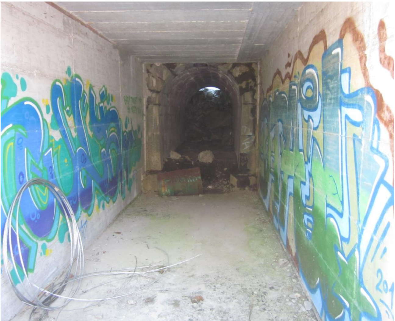
Fig. 6 – Immagine da sopralluogo – vista da valle n.1
