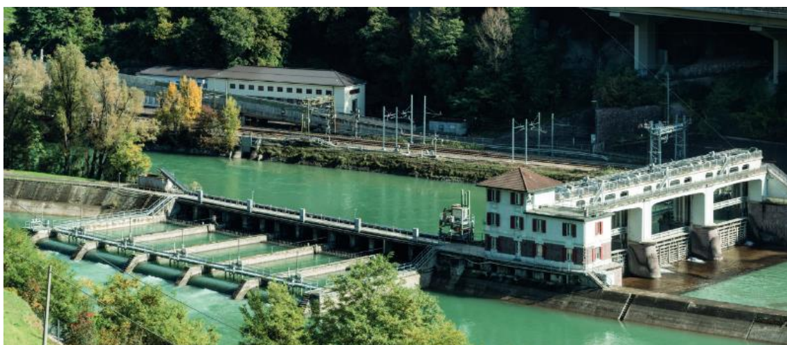
Fig. 4 – La restituzione dell’impianto di Barbiano / Ponte Gardena e l’opera di presa di Colma (BZ).
