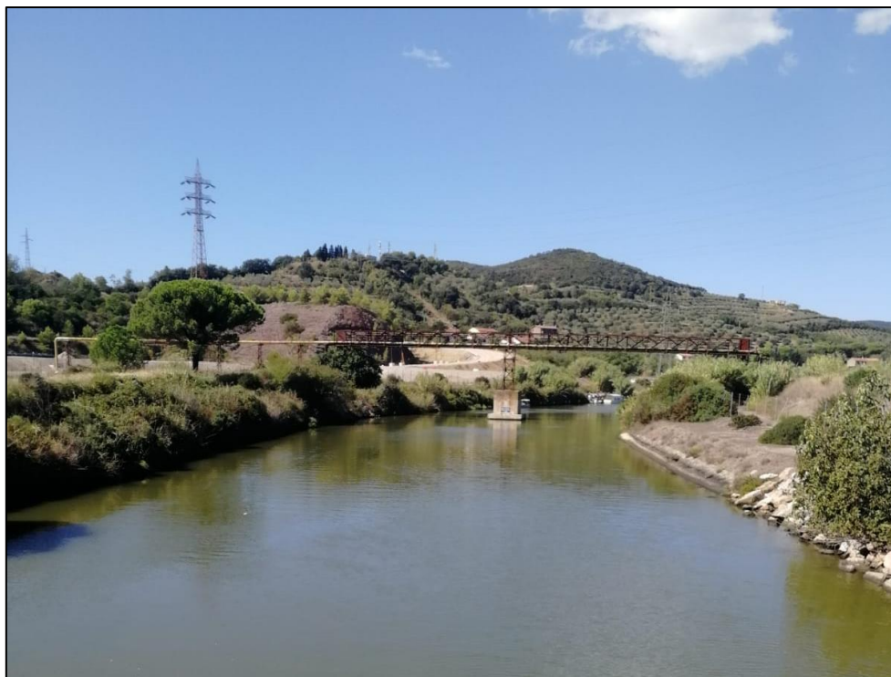
Figura 6 Punto di monitoraggio ASP06
