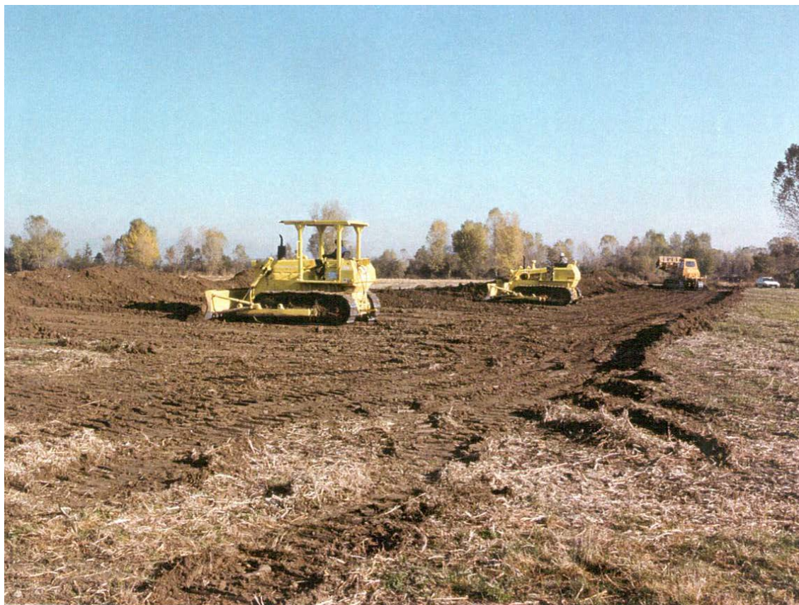
Foto 2.C: Esempio di apertura dell'area di passaggio
