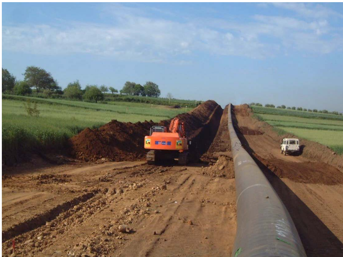
Foto 2.F: Esempio di scavo in trincea
