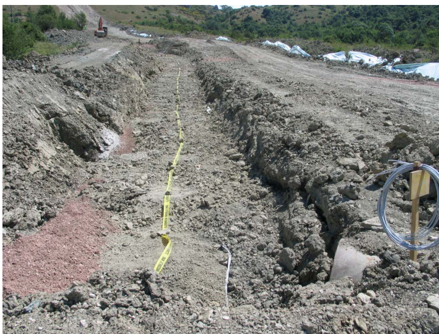
Foto 2.H: Esempio di rinterro della condotta
