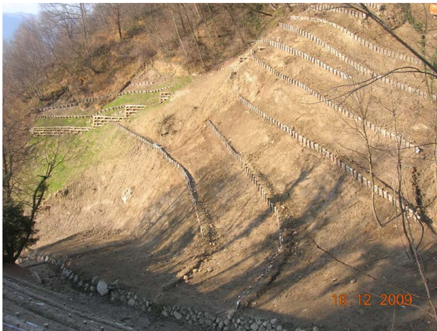
Foto 2.L: Esempio di ripristino morfologico e consolidamento di un versante con opere di ingegneria naturalistica (palizzate e palificate)
