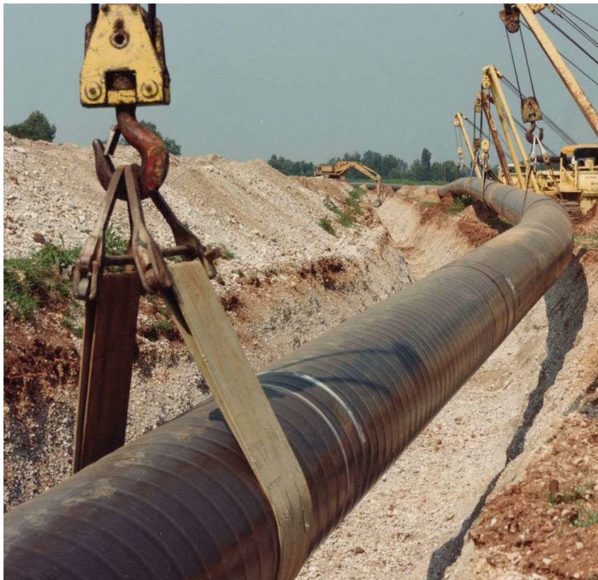
Foto 2.G: Esempio di posa della condotta
