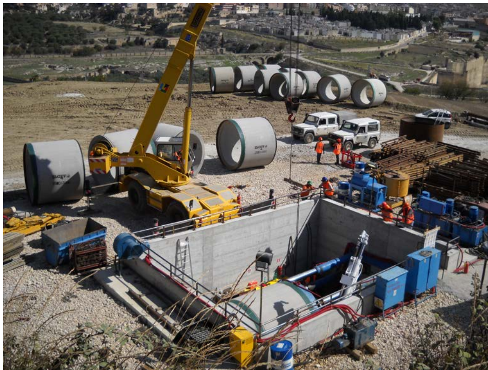
Foto. 2.E: esempio di una postazione di spinta di un Microtunnel
