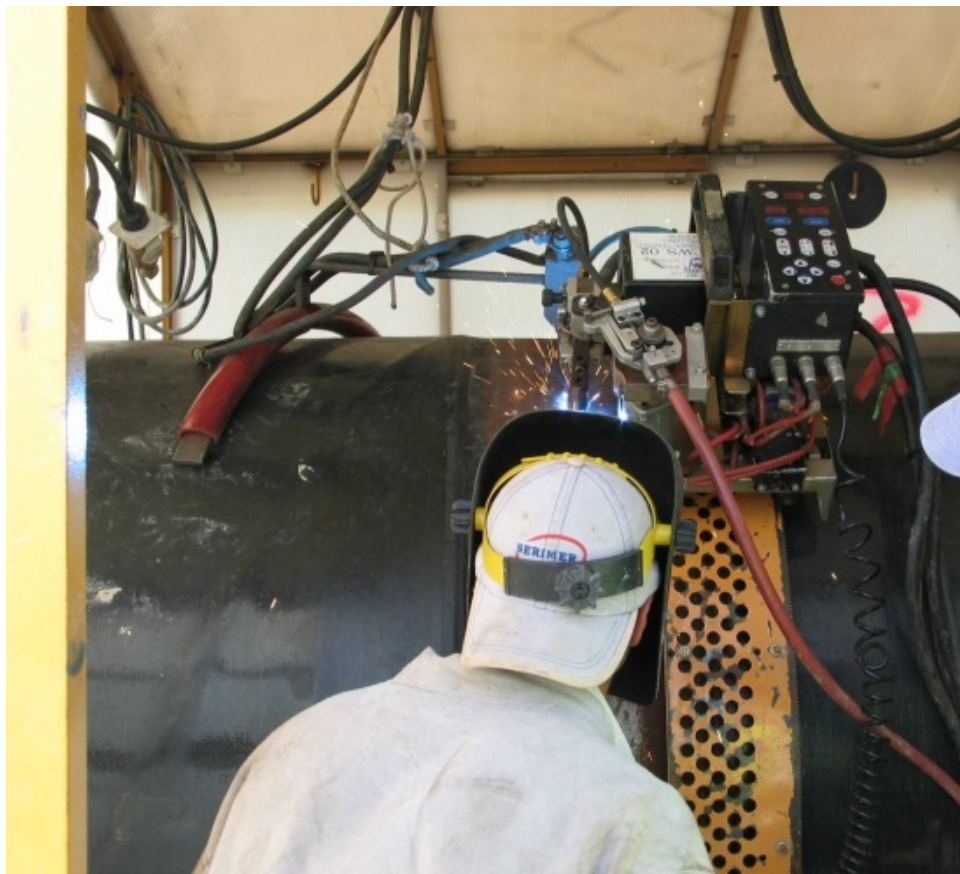
Foto 2.E: Esempio di saldatura di linea
