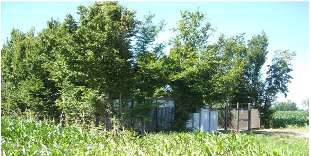
Foto 2.N: Esempio di mascheramento di impianto di linea
