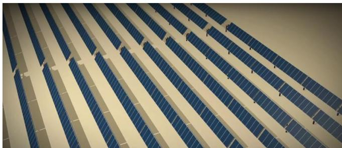
*Figura 5-3: esempio di inseguitore monoassiale+*
