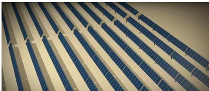
Figura 11. Esempio di inseguitore monoassiale
