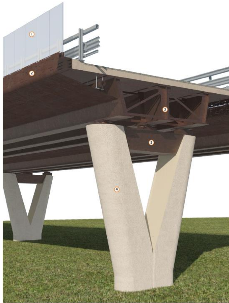
Figura 4-2 Soluzione con sabbiatura del calcestruzzo per le pile del viadotto SP7
