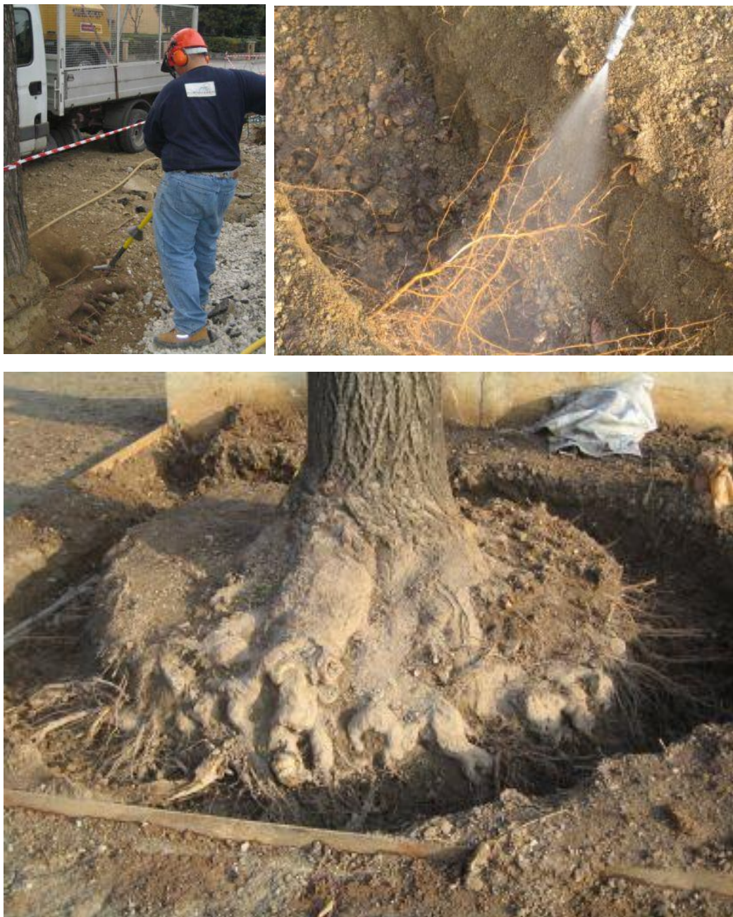
Figura 3-13 Ispezioni apparato radicale con tecnologia AIR SPADE®
