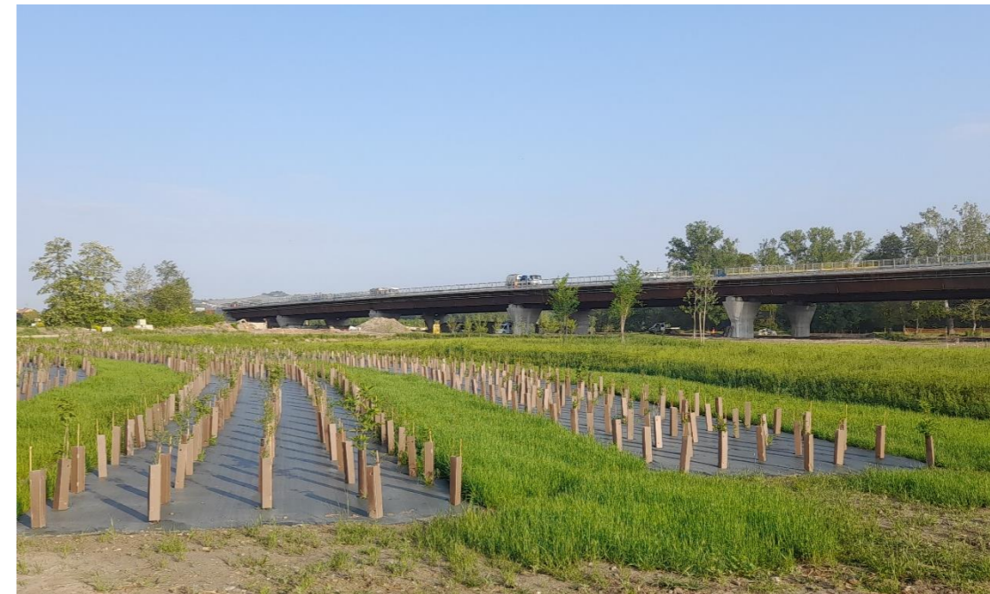
FIGURA 2-1 VISTA COMPLESSIVA DEL PONTE TALLORIA
