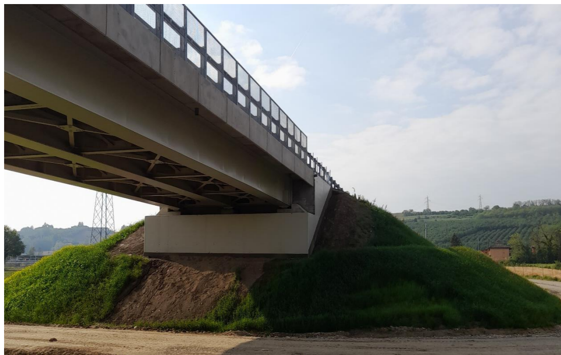
FIGURA 2-17 CAVALCAVIA STRADA CAMPESTRE ALLA PROGR. 5+915.15 – VISTA DELLA STRUTTURA DELL'IMPALCATO IN APPOGGIO ALLA SPALLA
