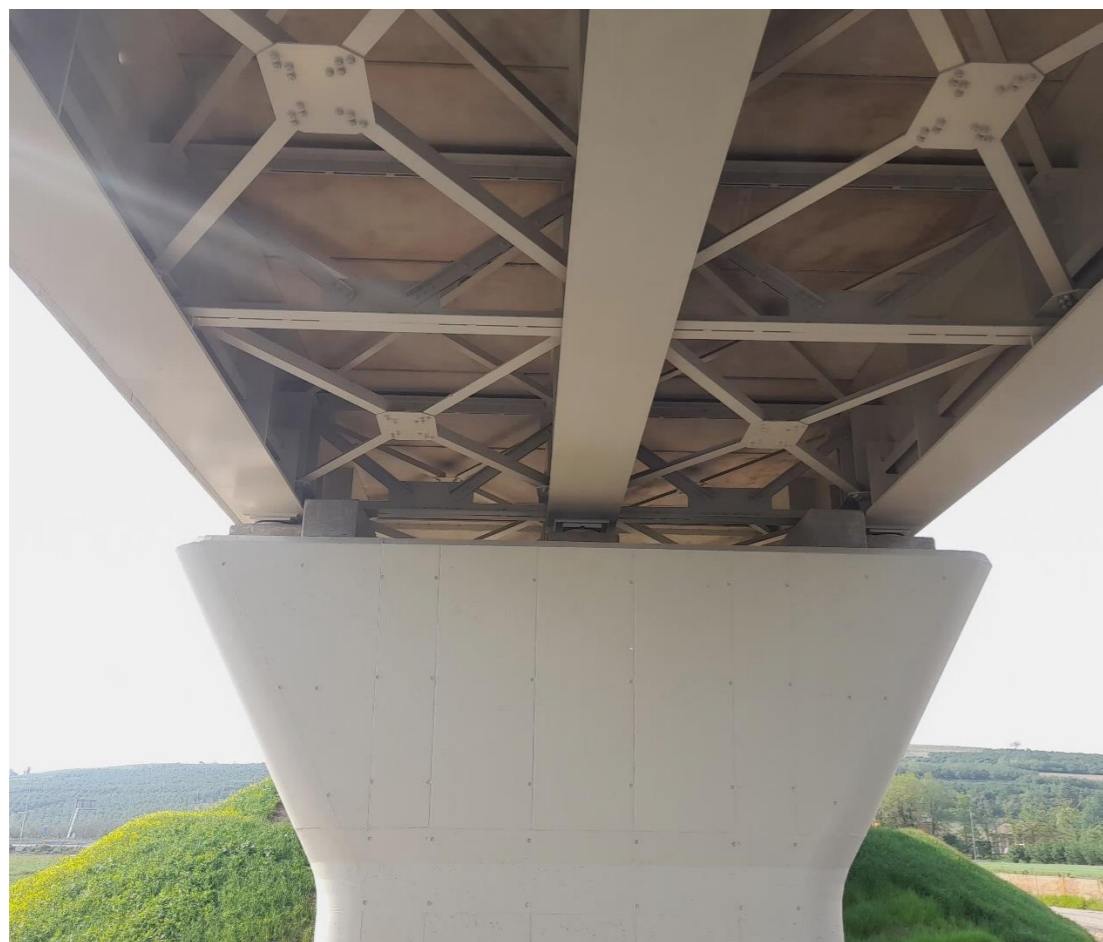
FIGURA 2-18 CAVALCAVIA STRADA CAMPESTRE ALLA PROGR. 5+915.15 – VISTA DI DETTAGLIO DEL PULVINO, DEGLI APPOGGI, DEL SISTEMA DI RITENUTA ANTISISMICA E DELLA STRUTTURA DELL'IMPALCATO A TRE TRAVI VERTICALI
