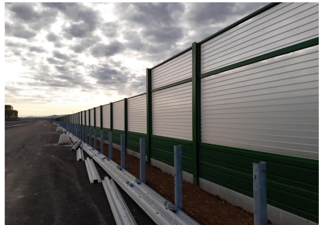
FIGURA 2-23 PARTICOLARE BARRIERA ANTIRUMORE - LATO SORGENTE (CARREGGIATA)
