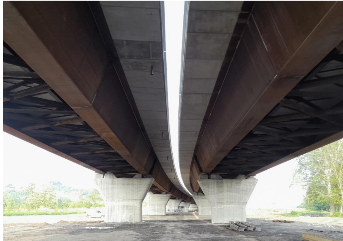
FIGURA 2-3 PARTICOLARE INTRADOSSO IMPALCATO E LASTRE PREDALLES PREFABBRICATE
