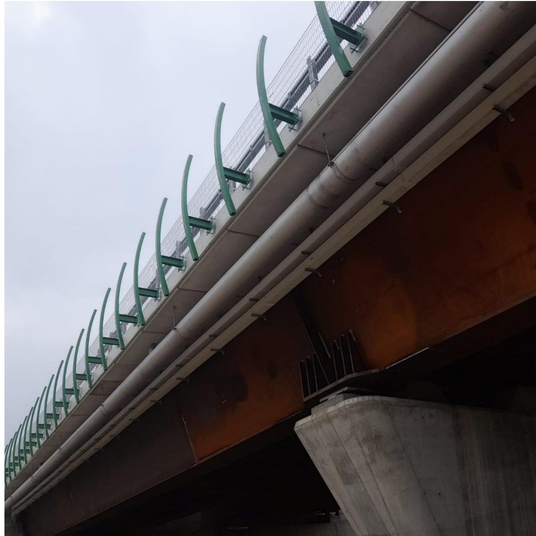
FIGURA 2-24 VIADOTTO IN ASSE AUTOSTRADALE: PARTICOLARE DEL COLLETORE DELLE ACQUE METEORICHE. SI NOTINO LE STAFFE DI SUPPORTO PER IL CARTER LATERALE, POSIZIONATO A PARZIALE MASCHERAMENTO DEL SISTEMA.
