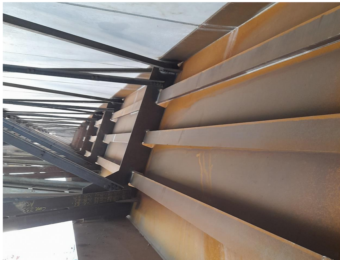
FIGURA 2-8 PARTICOLARE VISTA INTERNA DELLA TRAVE INCLINATA DI BORDO (SI NOTINO GLI ELEMENTI DI IRRIGIDIMENTO DELL'ANIMA, PRESENTI SOLO INTERNAMENTE)
