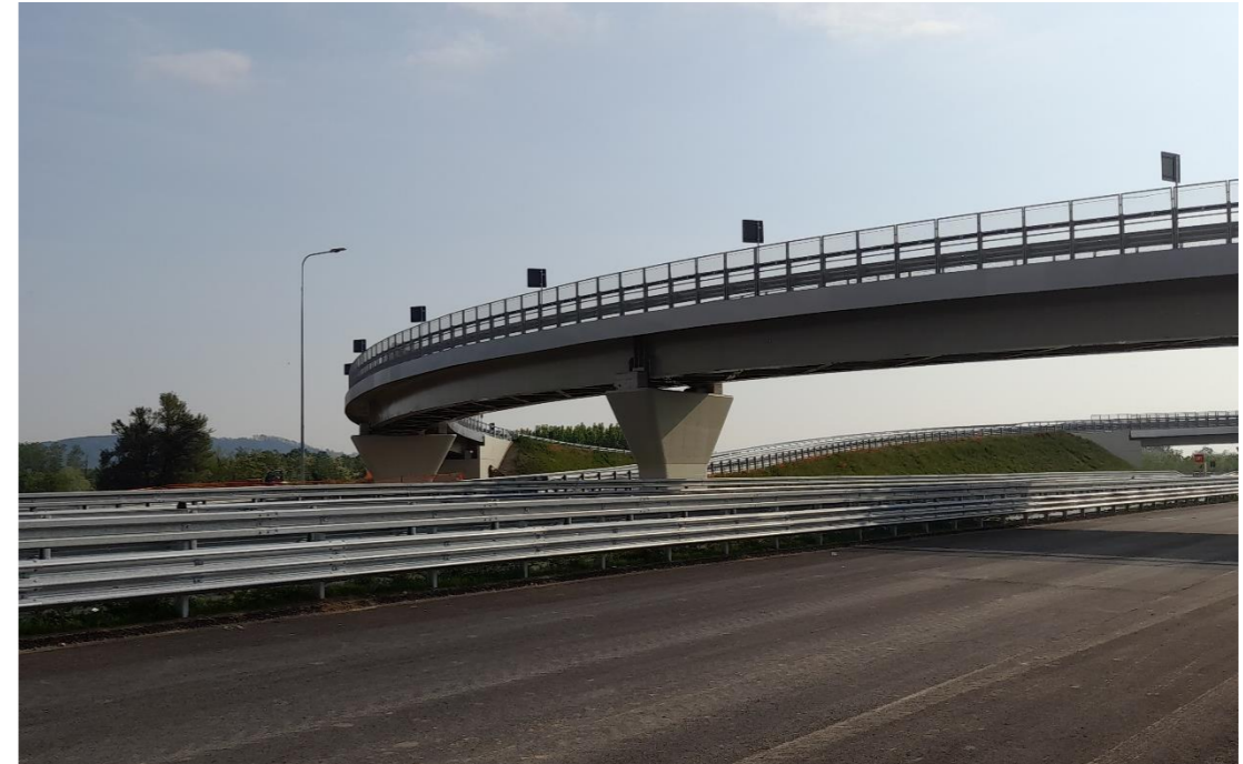
FIGURA 2-11 RAMPA DI USCITA ASTI-ALBA OVEST – VISTA DELLO SVILUPPO CURVILINEO DELL'IMPALCATO
