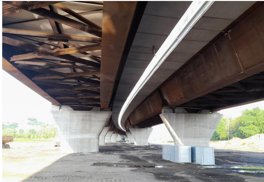
FIGURA 2-4 PARTICOLARE INTRADOSSO IMPALCATO E LASTRE PREDALLES PREFABBRICATE
