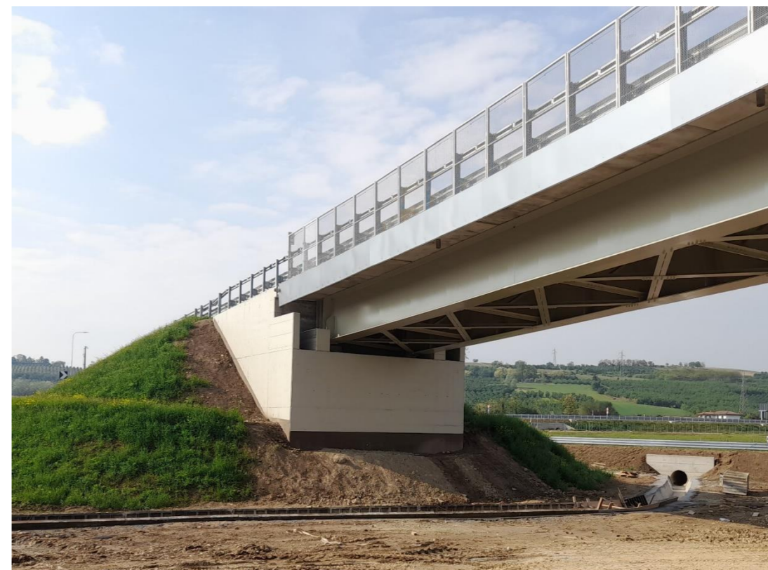
FIGURA 2-19 RAMPA DI USCITA ASTI-ALBA OVEST – VISTA DELLA SEZIONE DI RACCORDO FRA GLI ELEMENTI ED I DISPOSITIVI DI MARGINE INSTALLATI SUL VIADOTTO ED IL CORPO SPALLA
