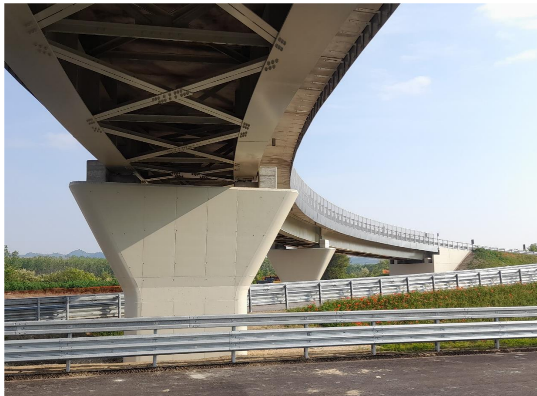
FIGURA 2-13 RAMPA DI USCITA ASTI-ALBA OVEST – VISTA DELLA PILA E DEL SISTEMA DEGLI APPOGGI E DEGLI ELEMENTI DI RITENUTA ANTISMICI
