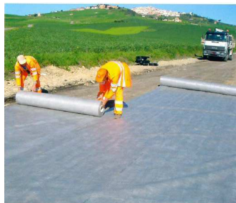
posa geostuoioia di separazione
