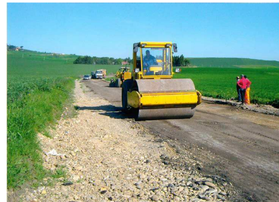
realizzazione strato di usura
