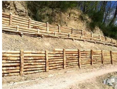
Figura 7 - esempio di palizzata
