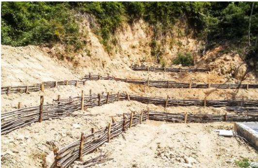
Figura 6 - esempio di realizzazione di una viminata
