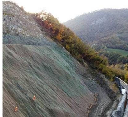
Figura 5 – sistema di applicazione idrosemina
