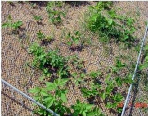
Figura 4 – particolare della vegetazione che cresce attraverso la biostuoia in cocco
