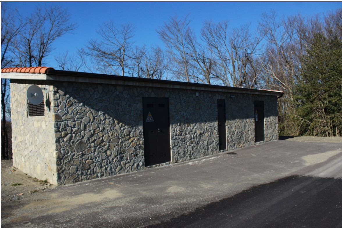
Figura 2 - esempio di cabina elettrica mitigata
