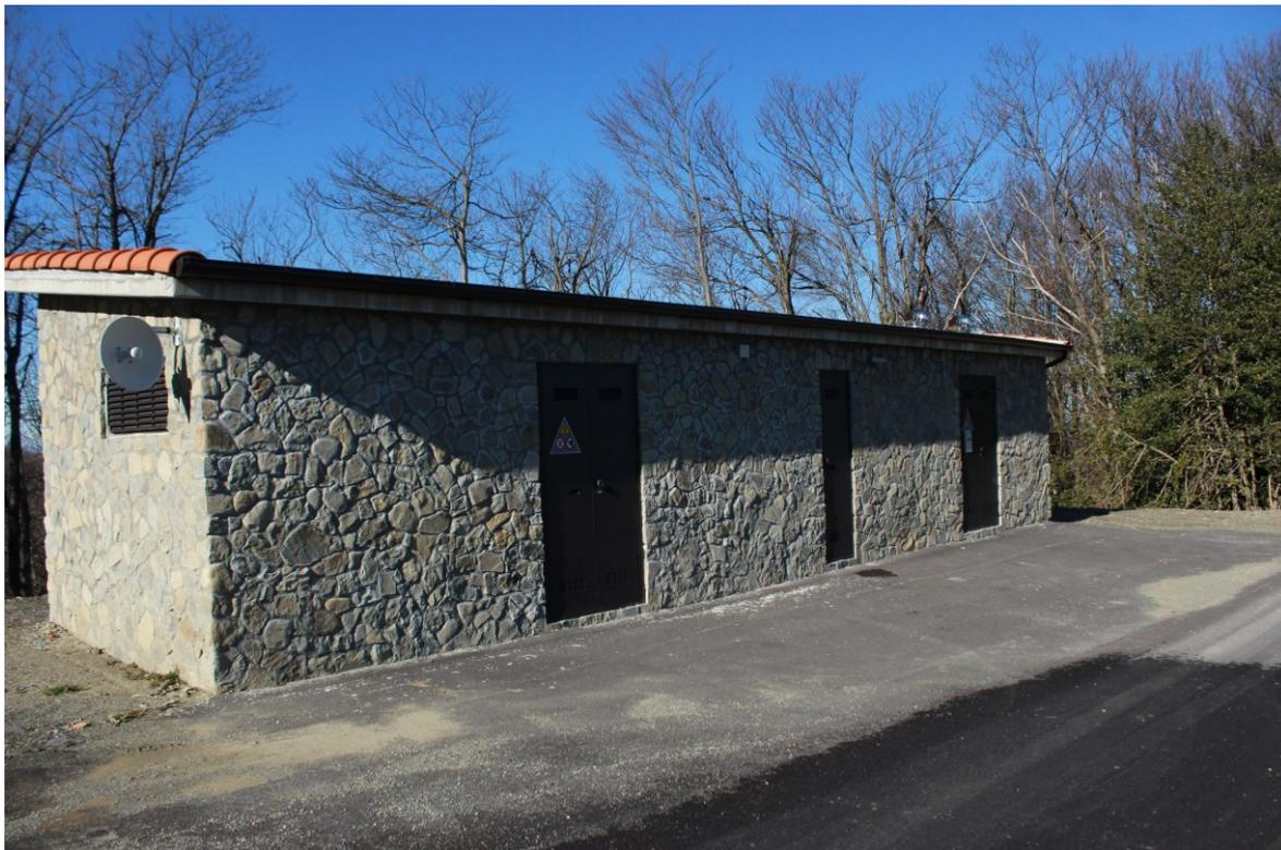
Figura 2 - esempio di cabina elettrica mitigata
