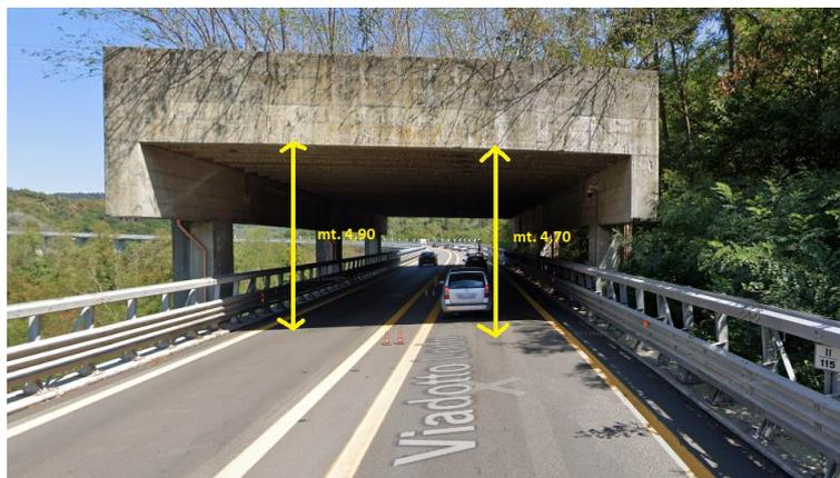
*Figura 18 – Interferenza critica della struttura atta alla protezione della funivia ivi presente*
