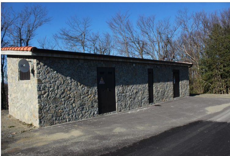
Figura 18 - esempio di cabina elettrica mitigata
