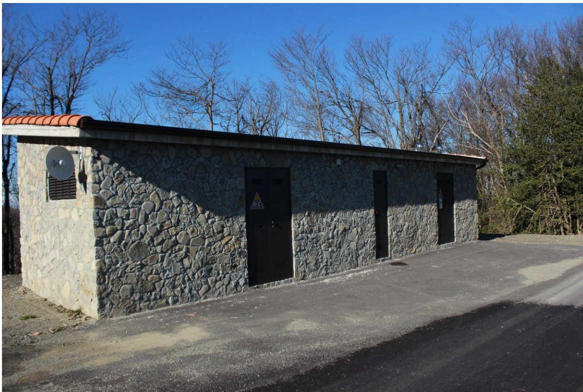
Figura 8 - esempio di cabina elettrica mitigata
