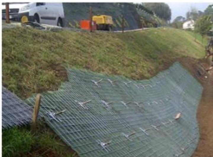
**Figura 33**      **Dettagli reti in acciaio**
