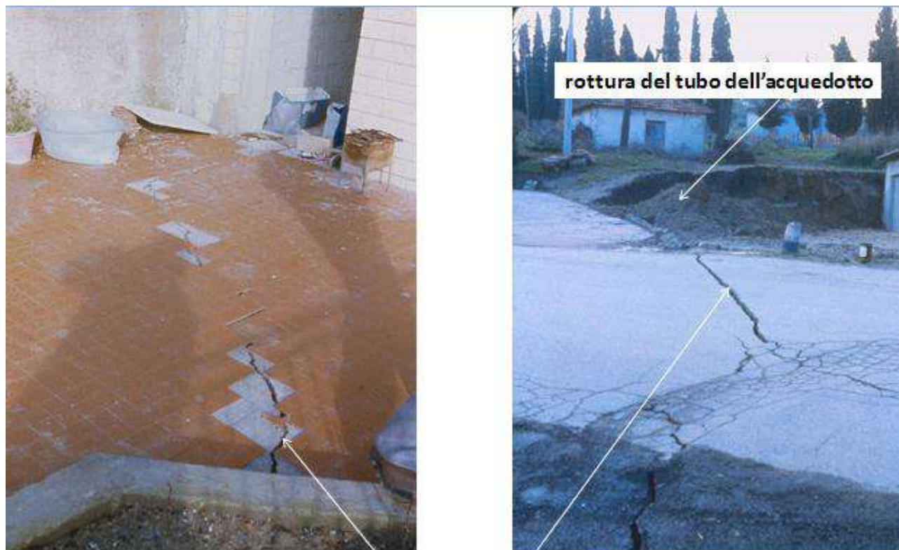
Fig. 34 - Fagliazione delle rocce lungo i crinali della dorsale di Monte Forcuso e dei Monti della Baronìa. In corrispondenza della frattura è stato tranciato il tubo dell'acquedotto.
