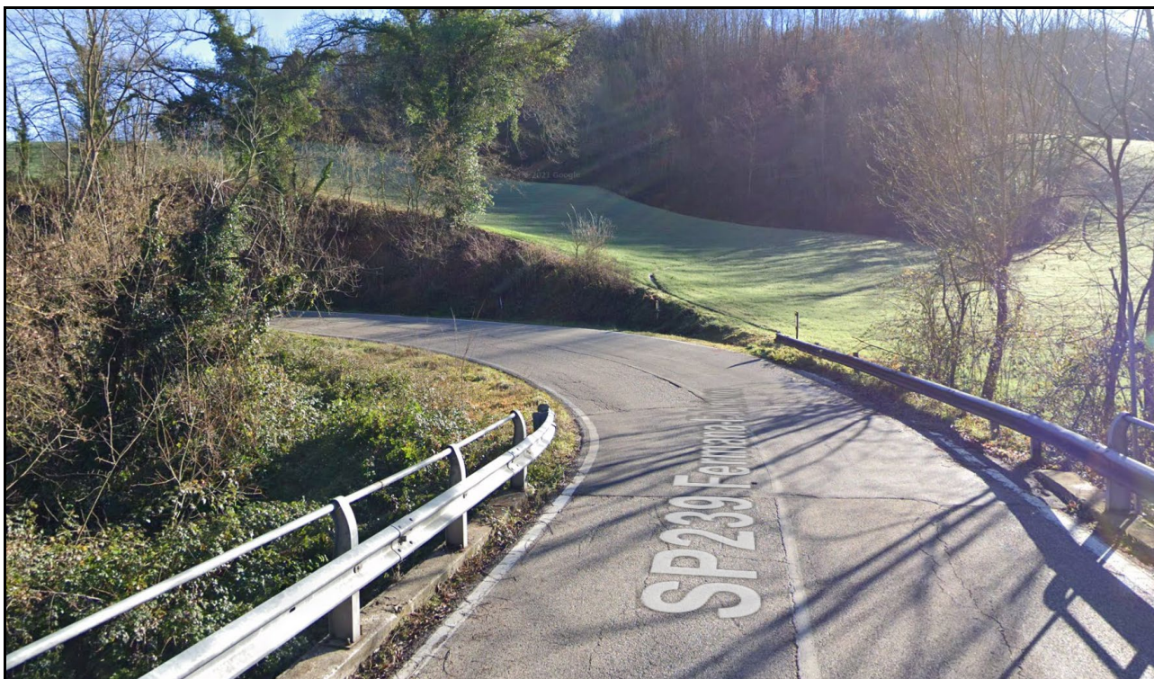
Fig. 4 – Larghezza ridotta della piattaforma e assenza di visibilità in curva
