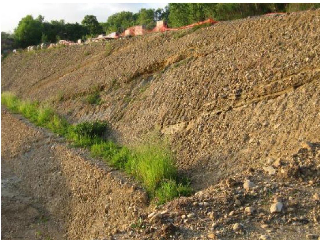
Figura 9-50: Scavo aperto in BTL-PLMa
