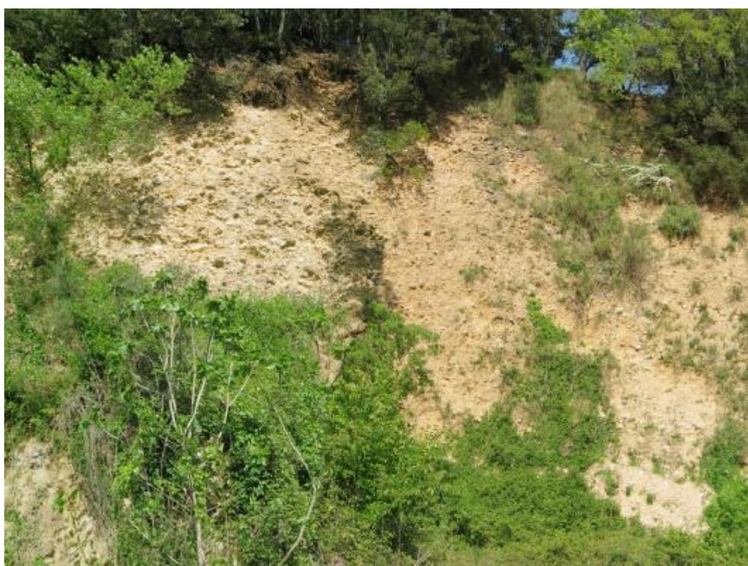
Figura 9-31: Parete sub-verticale costituita dai conglomerati LDC
