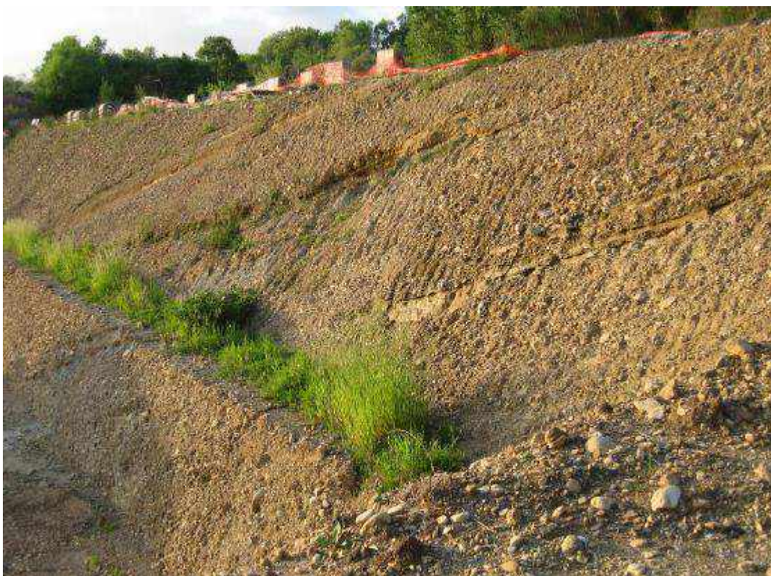
Figura 9-50: Scavo aperto in BTL-PLMa
