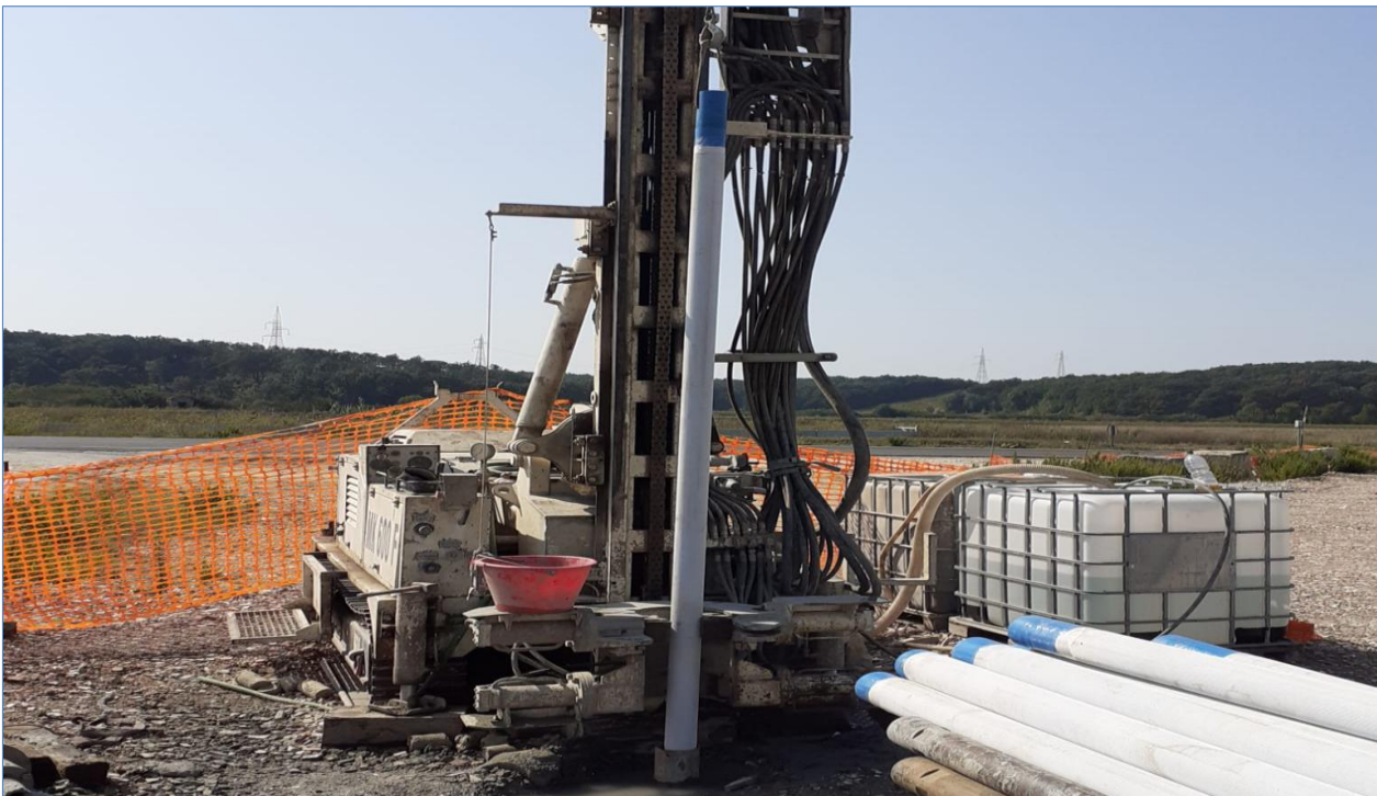
FASE ESECUTIVA INSTALLAZIONE PIEZOMETRO A TUBO APERTO
