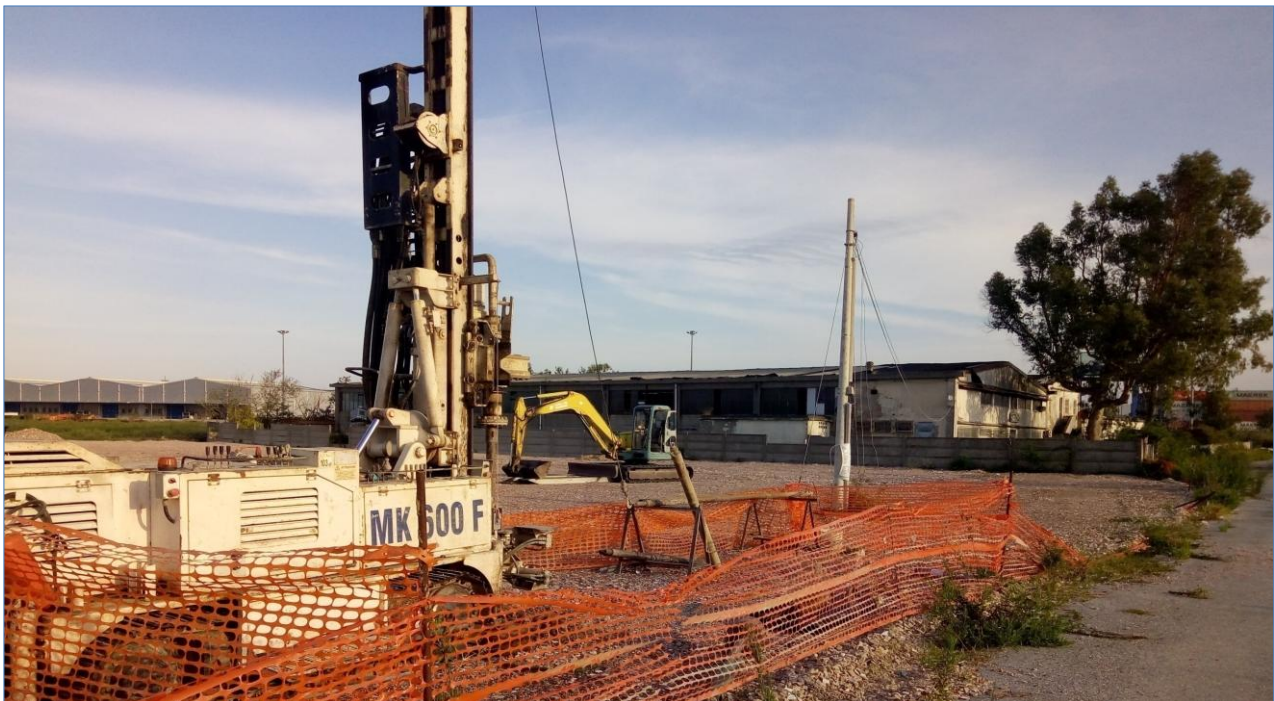
Postazione SONDAGGIO S1
