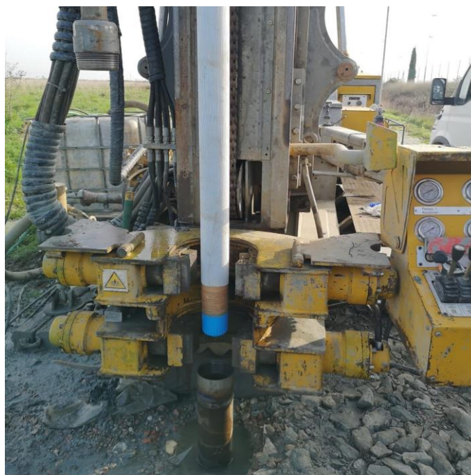
FASE ESECUTIVA INSTALLAZIONE PIEZOMETRO A TUBO APERTO
