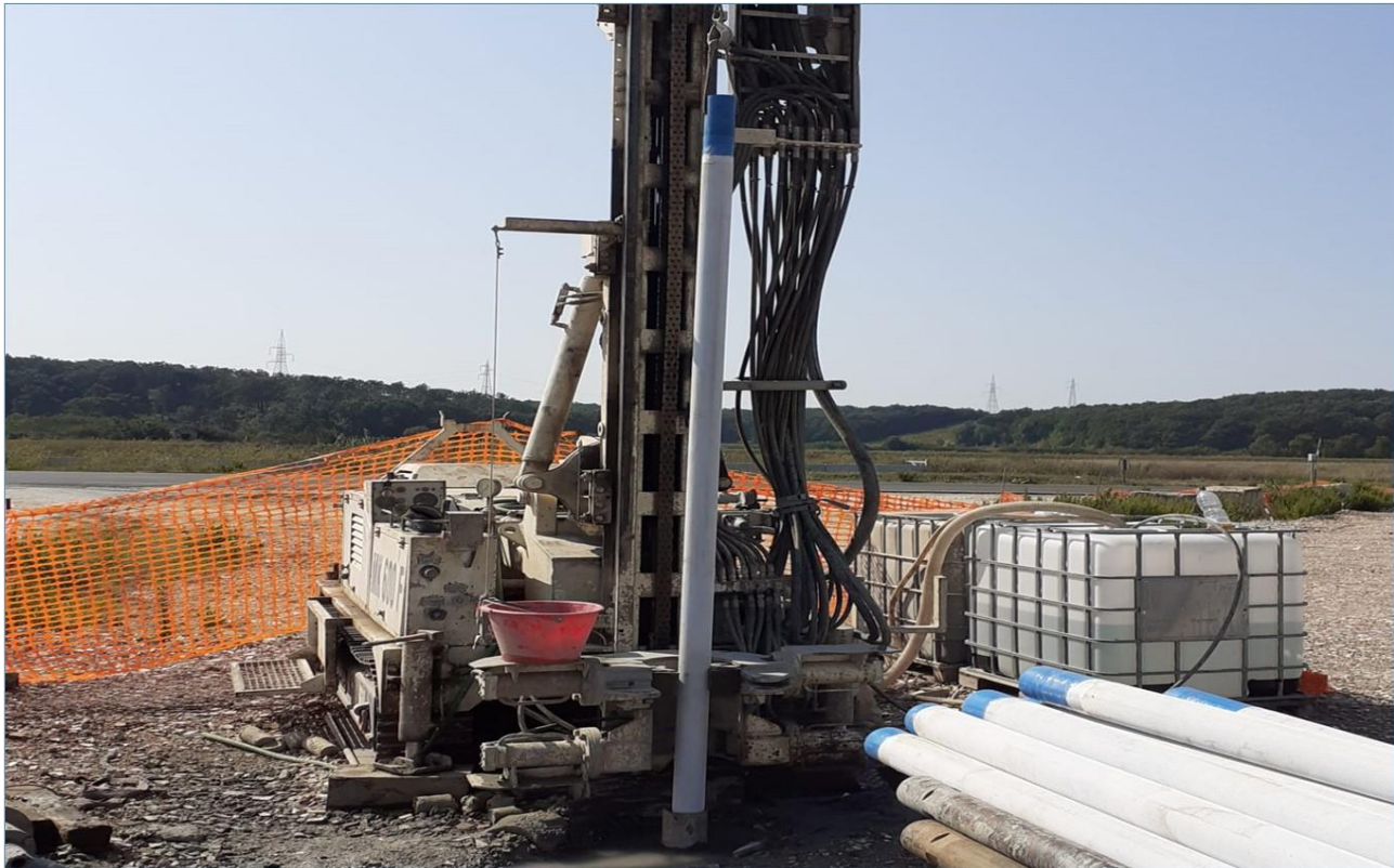
Figura 5: Installazione tubi piezometrici da 3"
