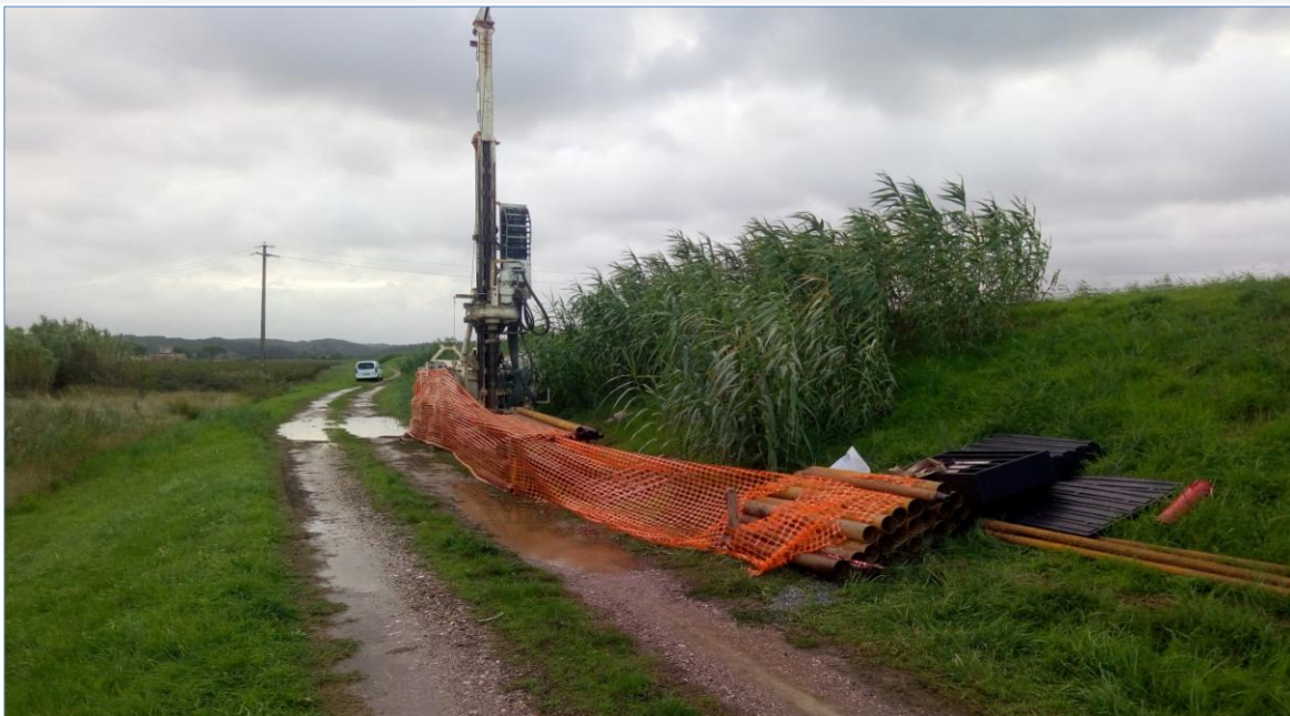
Postazione SONDAGGIO S2
