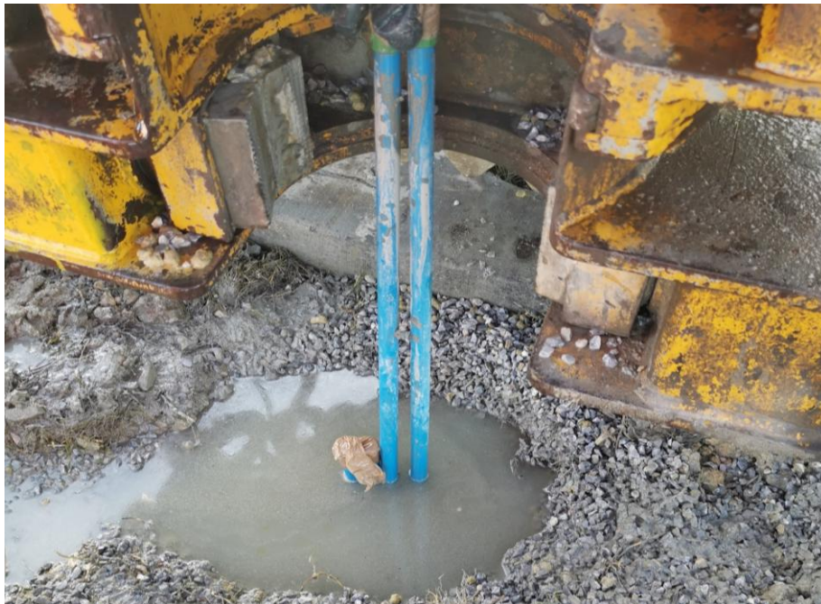
FASE ESECUTIVA INSTALLAZIONE PIEZOMETRI DI CASAGRANDE
