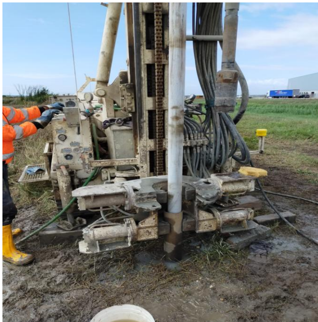
FASE ESECUTIVA INSTALLAZIONE PIEZOMETRO A TUBO APERTO
