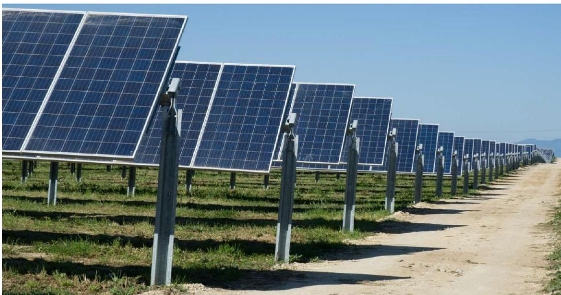
Figura 1 - immagine esemplificativa di inseguitori mono-assiali Convert 1P - configurazione 1P (fonte: Convert Valmont Solare)
