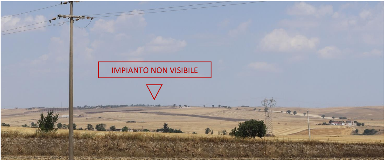
Figura 49: Vista dal Regio Tratturo Melfi – Castellaneta (antica Via Appia) – Ingrandimento di dettaglio
