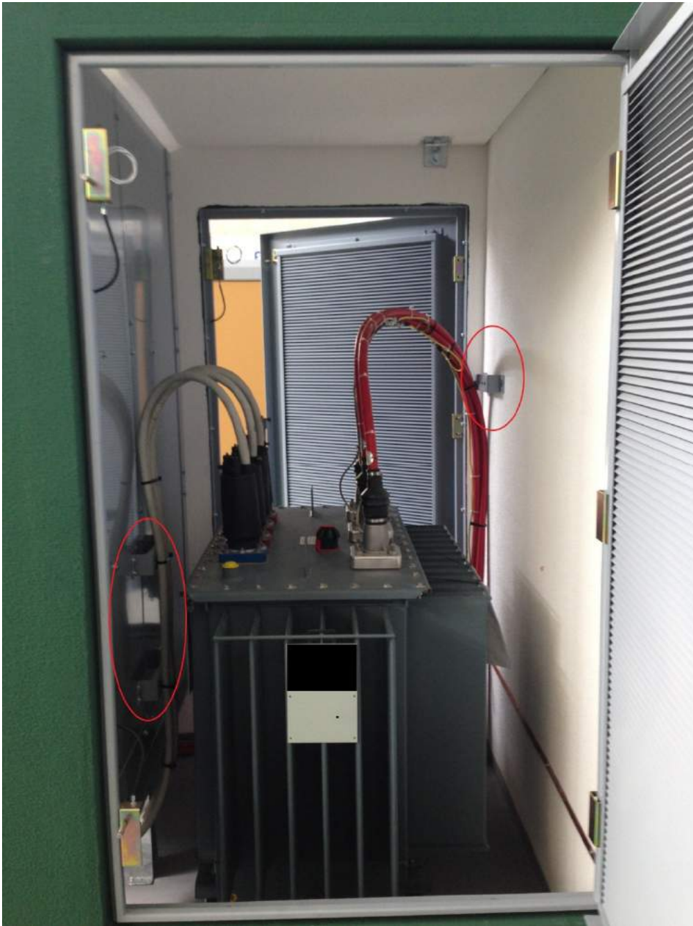
Figura 41 - posizione supporti cavo a parete
