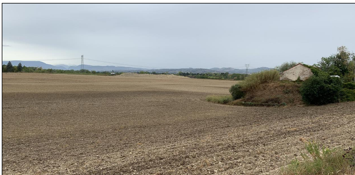
Foto n .4 – Indicazione della linea dell'elettrodotto
