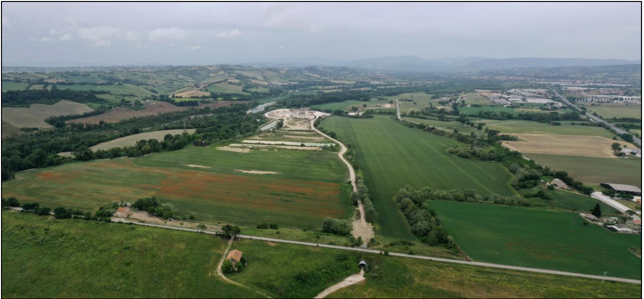
Figura 42 – Punto 01 vista dell'area senza interventi
