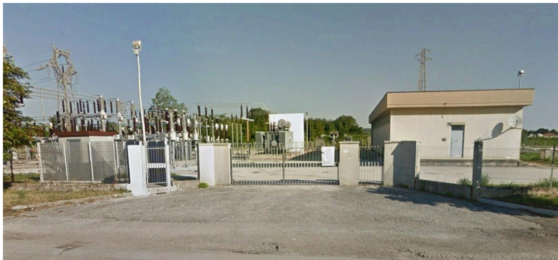
Figura 36 - Sottostazione AT-MT Immagine esemplificativa della stazione di progetto
