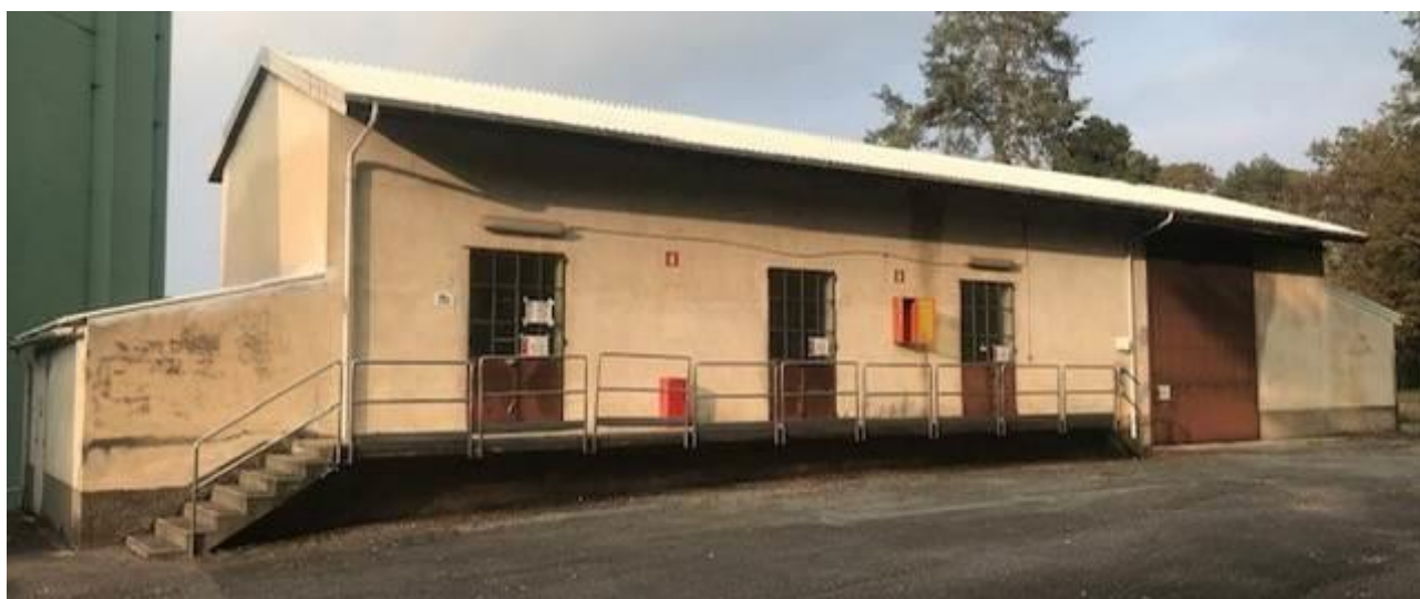
Figura 3-1. – Edificio 21c Stato dei luoghi
