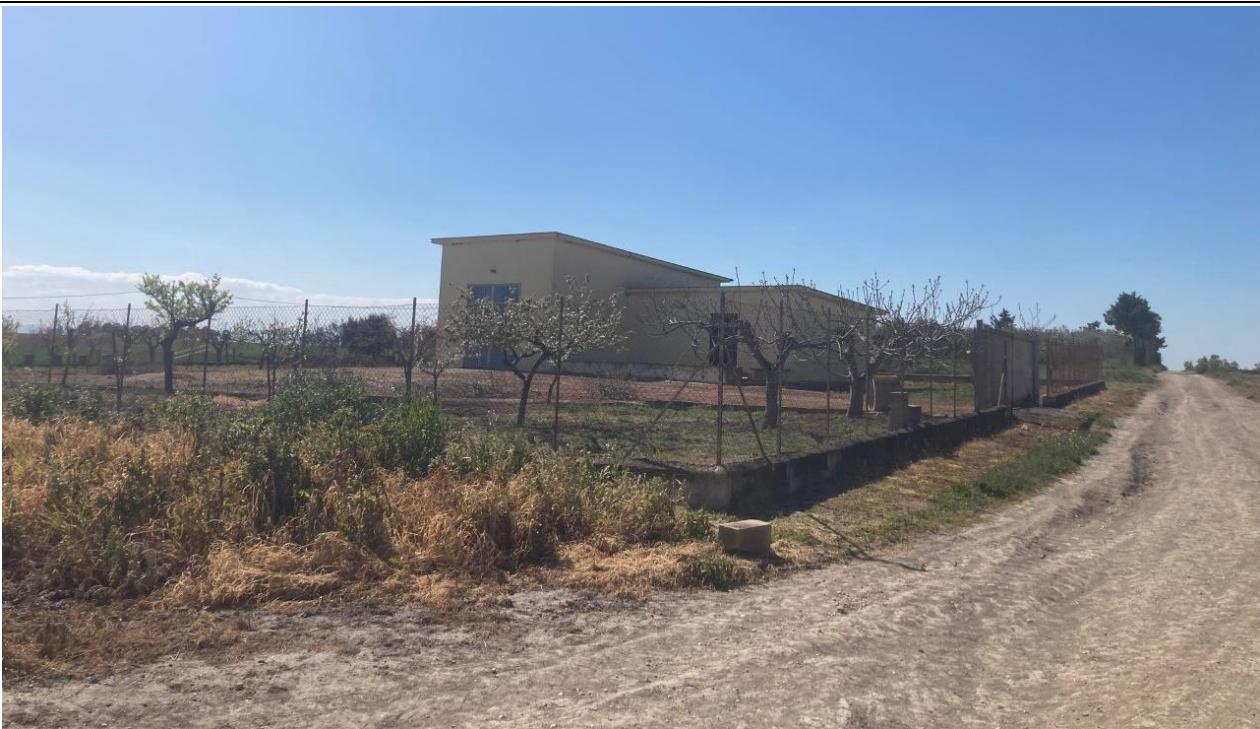
RILIEVO FOTOGRAFICO F – 9b
