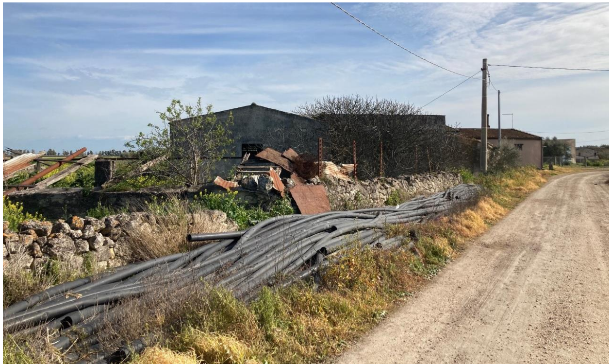
RILIEVO FOTOGRAFICO F - 4 b
