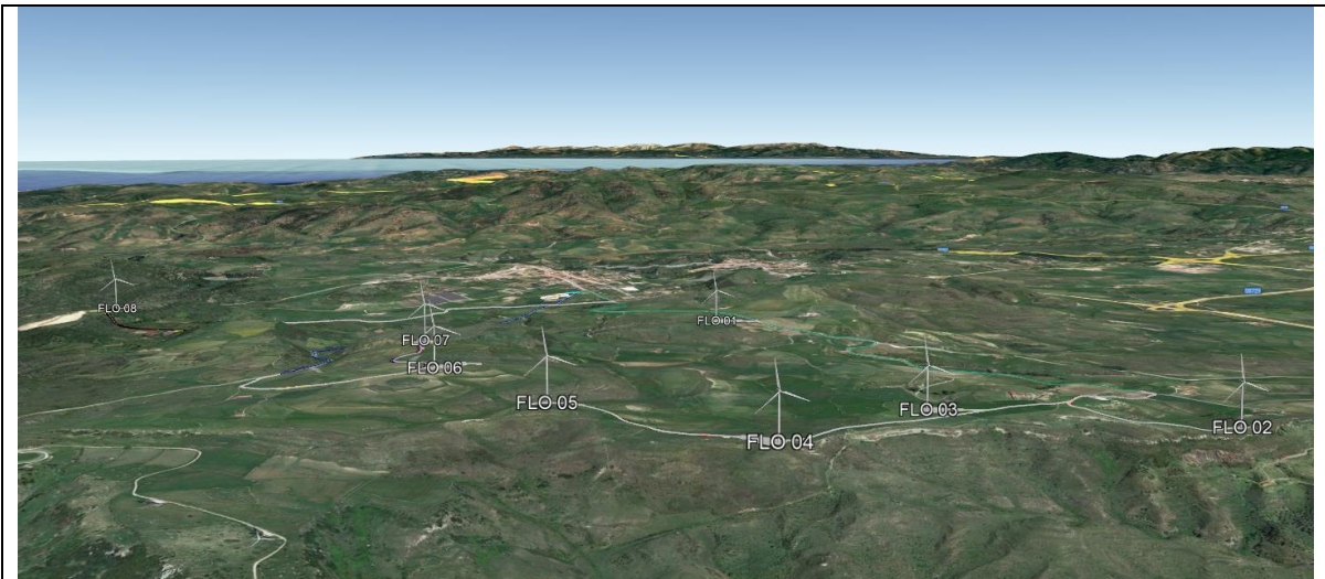
Fig. 6 - Vista degli aerogeneratori – inquadratura sud-nord
