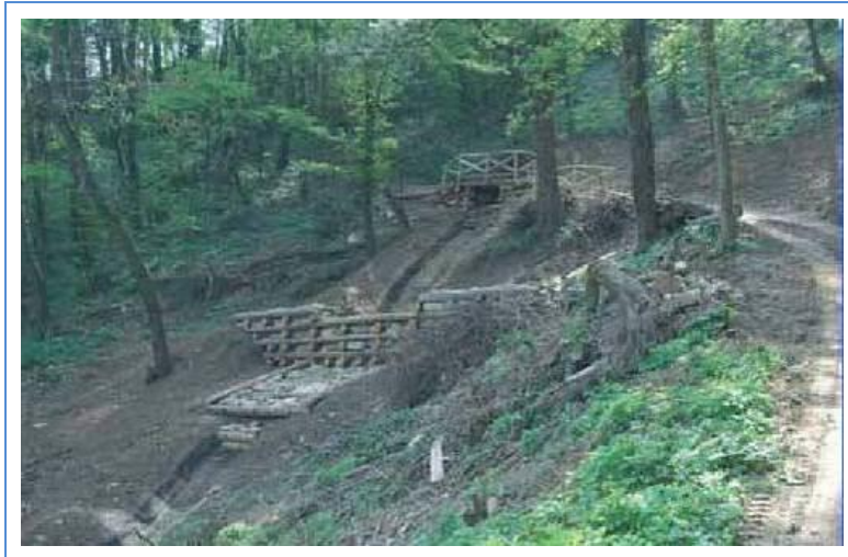
Figura 8.6 – Esempio di briglie in legname e pietrame - Fonte HE
