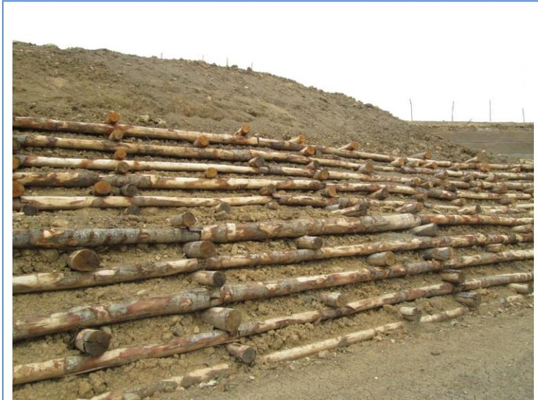
*Figura 48 – Esempio di opera in palificate in legname - Fonte HE*
