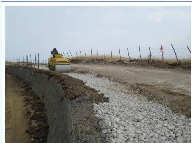
*Figura 49 – Esempio di opera in terre rinforzate - Fonte HE*
