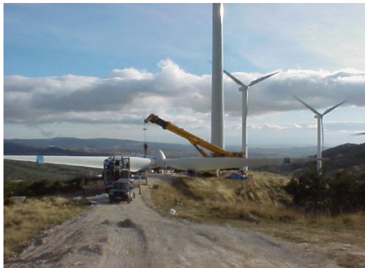
Figura 4-3: Ingombro del rotore a terra
