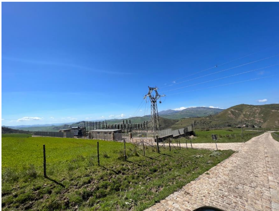
Punto di ripresa da terra n.0 (Sottostazione)
