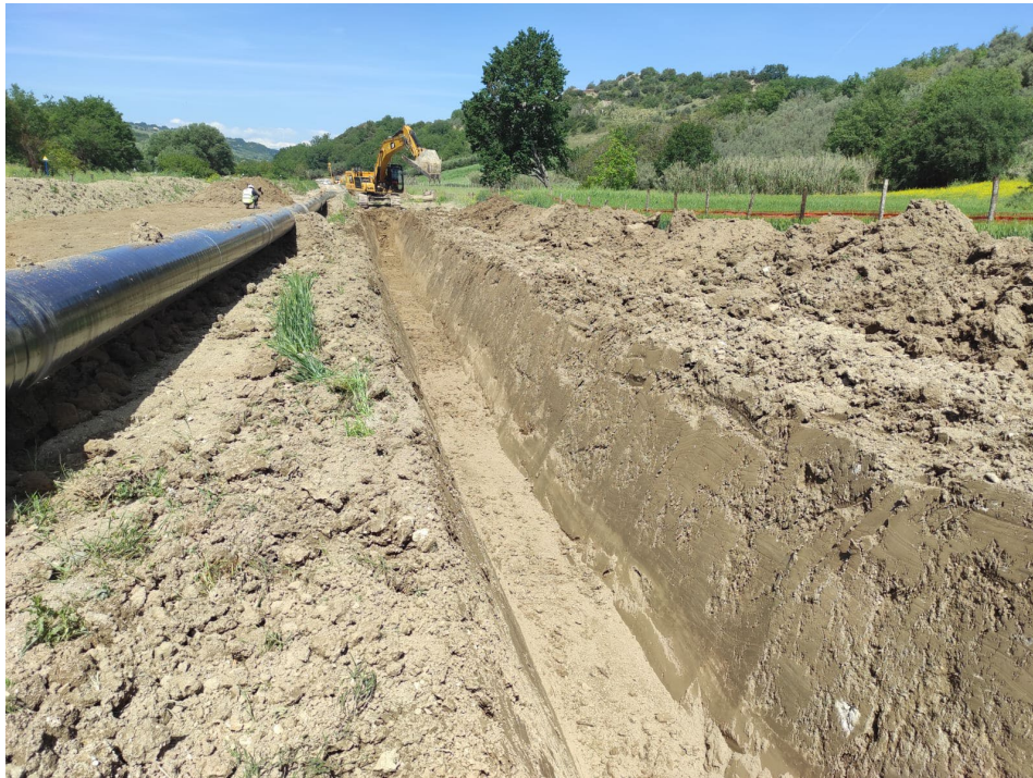
Fig. 2.8/B: Scavo della trincea – separazione tra terreno scavato (a destra) e l’humus precedentemente accantonato (a sinistra)
