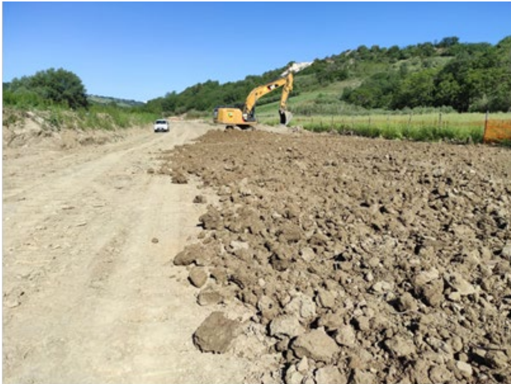
Fig. 2.8/C: Preparazione dello strato di contatto terreno-humus (riprofilatura)
