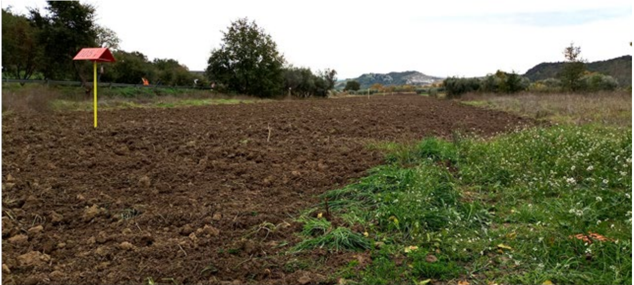
Fig. 2.8/D: Ripristino definitivo dello strato di terreno superficiale (humus)
