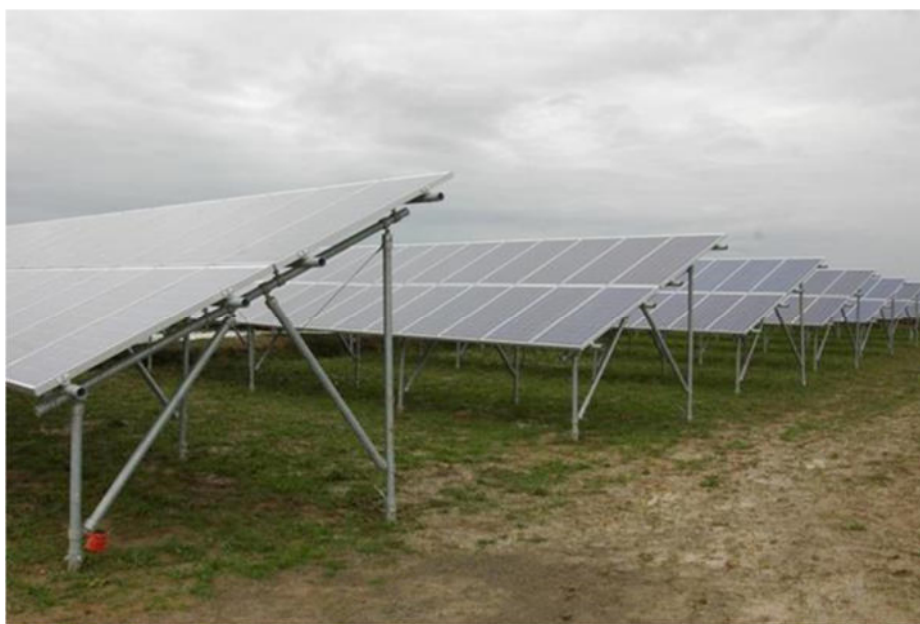
Figura 16: Esempio impianto a strutture fisse
