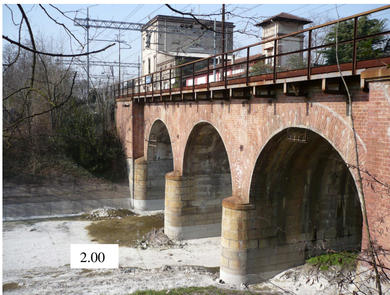
Figura 8-4 Scavalco del Villoresi - Impalcato esistente
