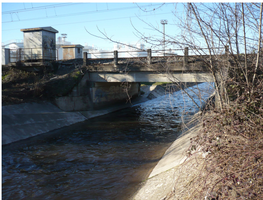
Figura 8-1 Foto dello stato esistente
