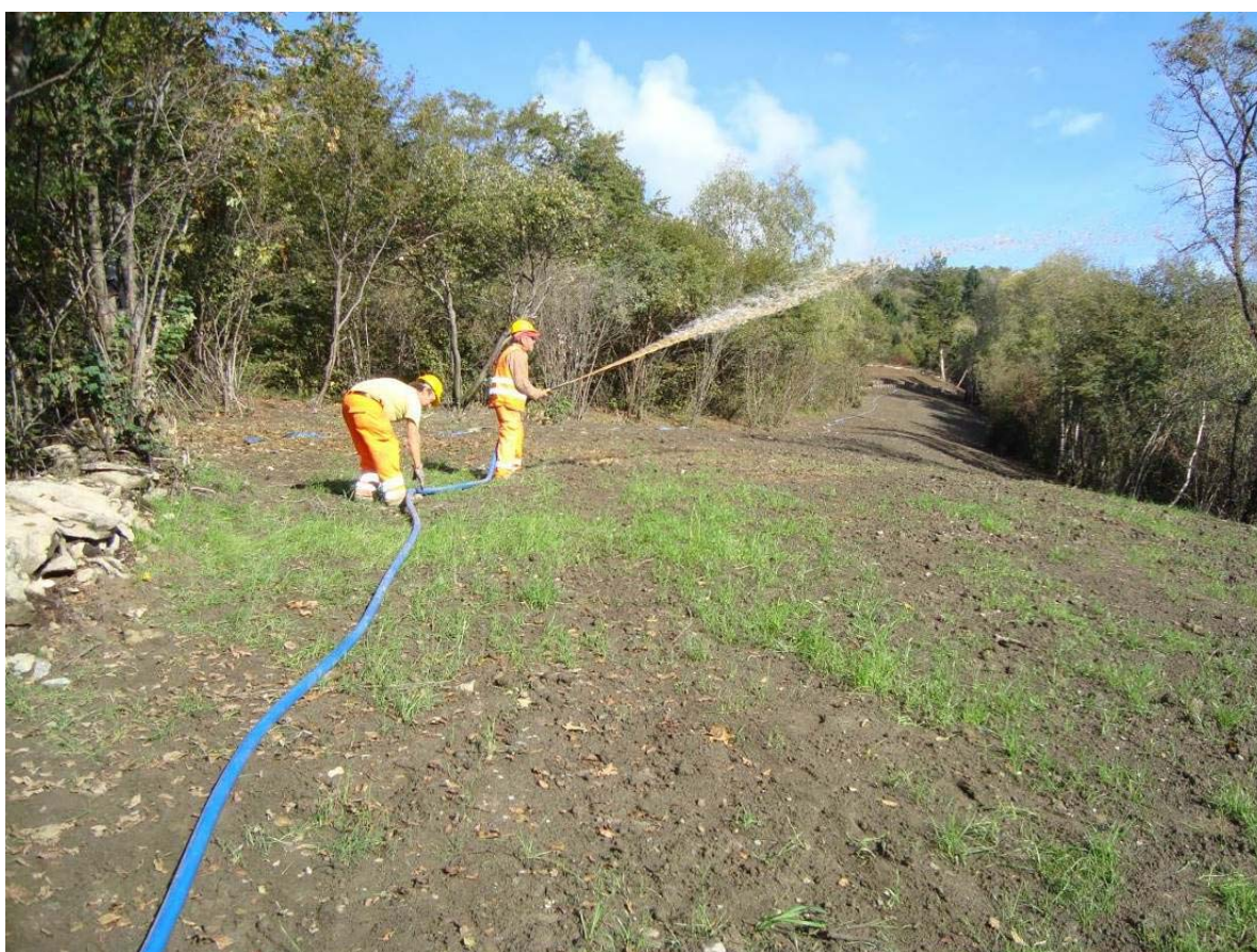
Fig. 4.1 - Distribuzione del miscuglio di semi per l'inerbimento e del quantitativo di fertilizzanti mediante idrosemina.
