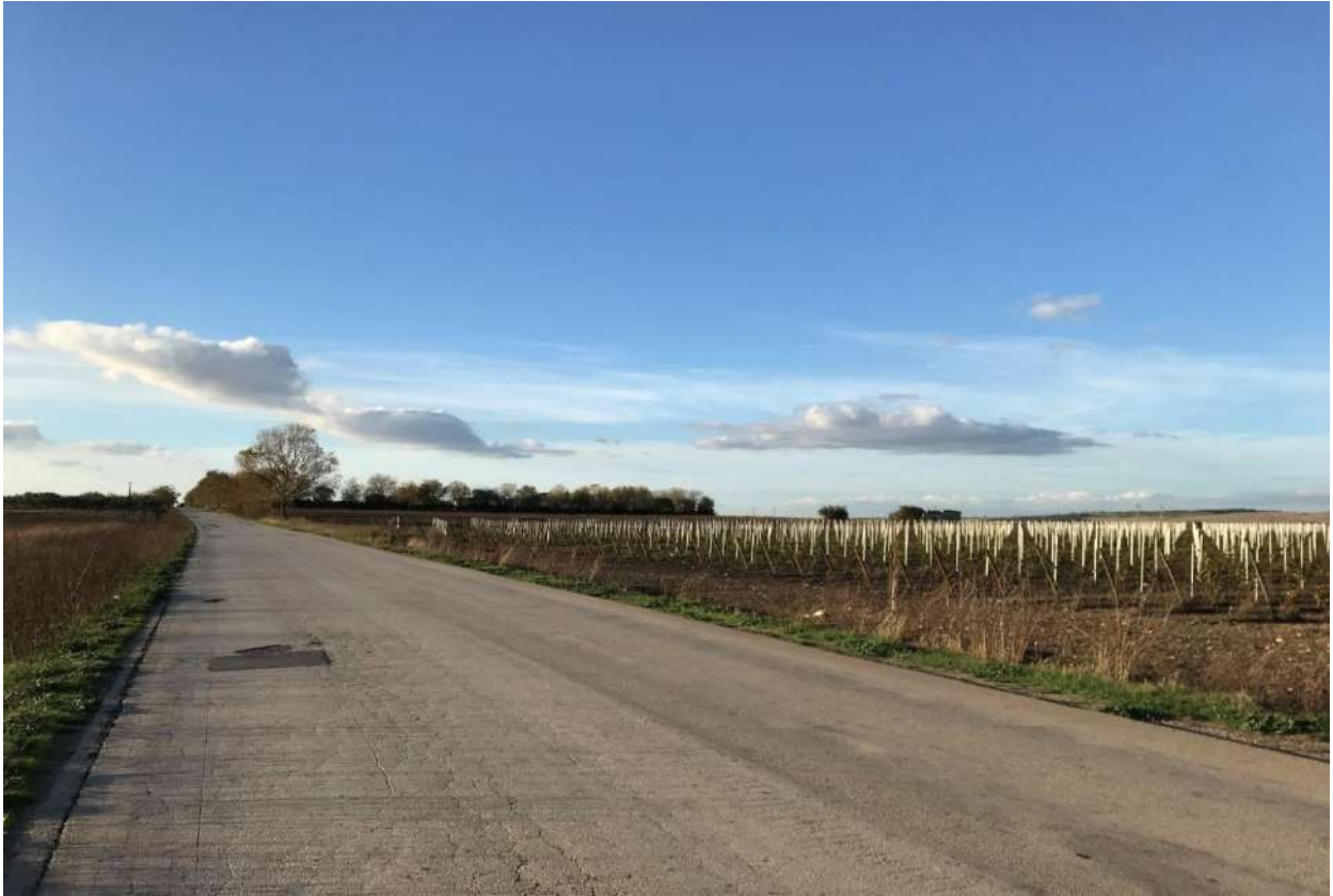
Figura 100. Punto di presa 20 Stato di Fatto ( SP140 – Appia ).
