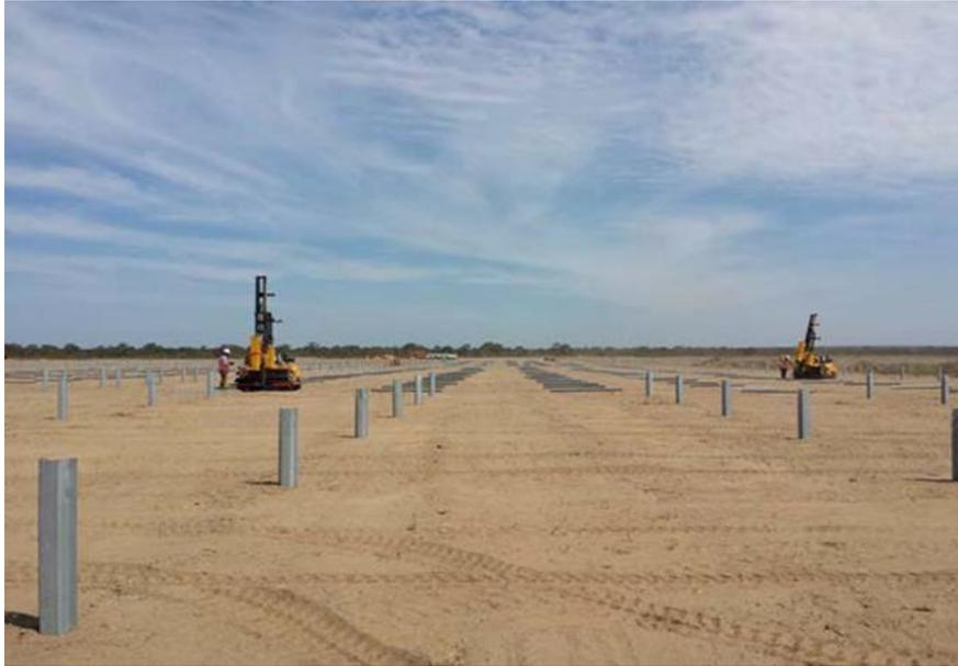
**Figura 12 – Posa in opera profili di palificazione**
