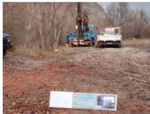
Postazione Sondaggio S5
