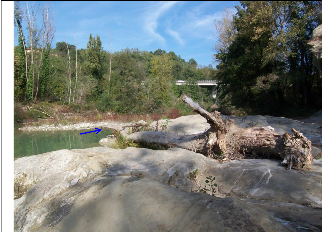
Foto 1: Ambito 1°Attraversamento Savio - vista da destra idrografica
