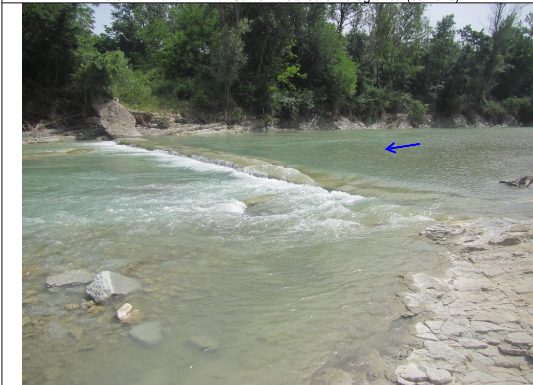
Foto 2: Soglia in c.a. a valle del 11°Attr. + affioramenti a dx e sx
