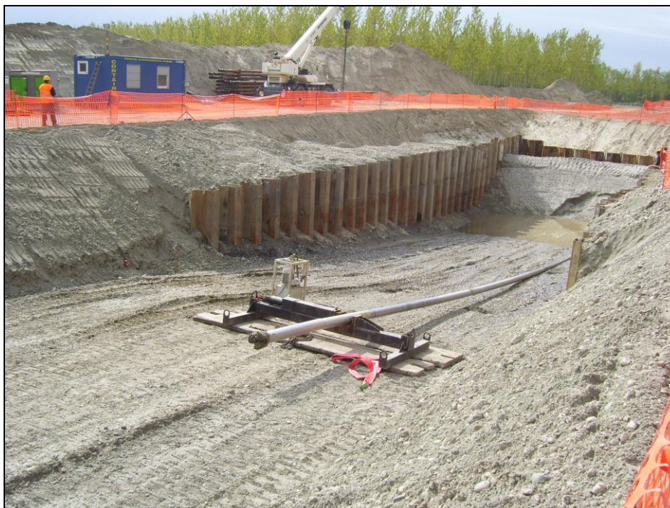
Fig.7.4/C: Attraversamento F. Po con met. 30” – fase di uscita dell’asta pilota
