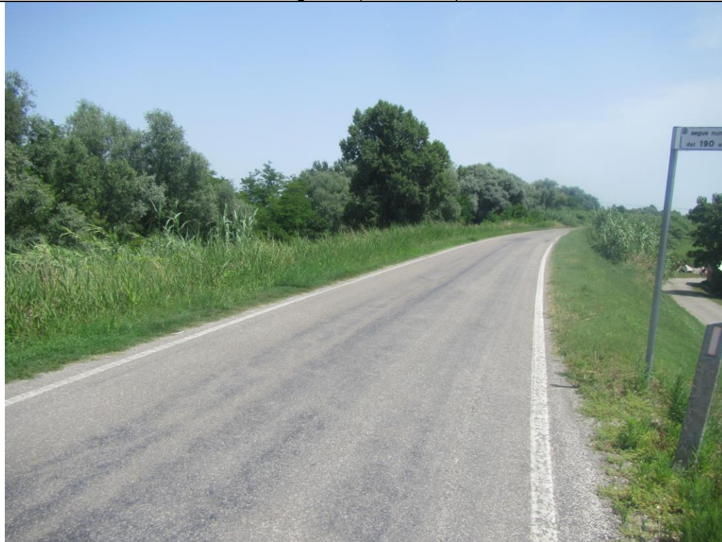
Foto 2: Montone- argine destro
