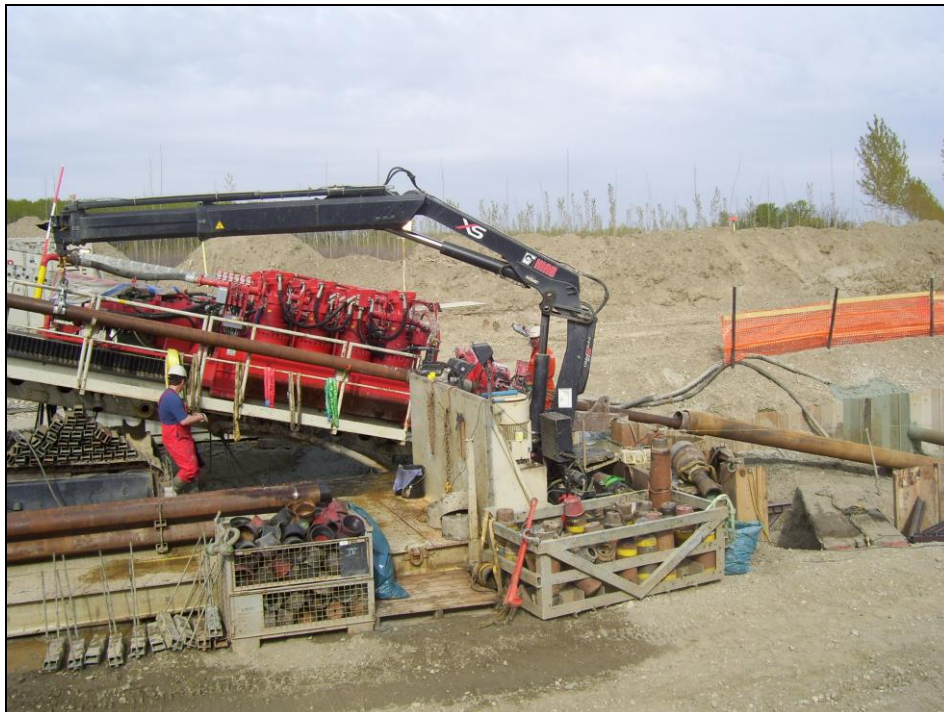
Fig.7.4/B: Attr.to F. Po con Met. DN30” – “Rig”, durante la realizzazione del foro pilota
