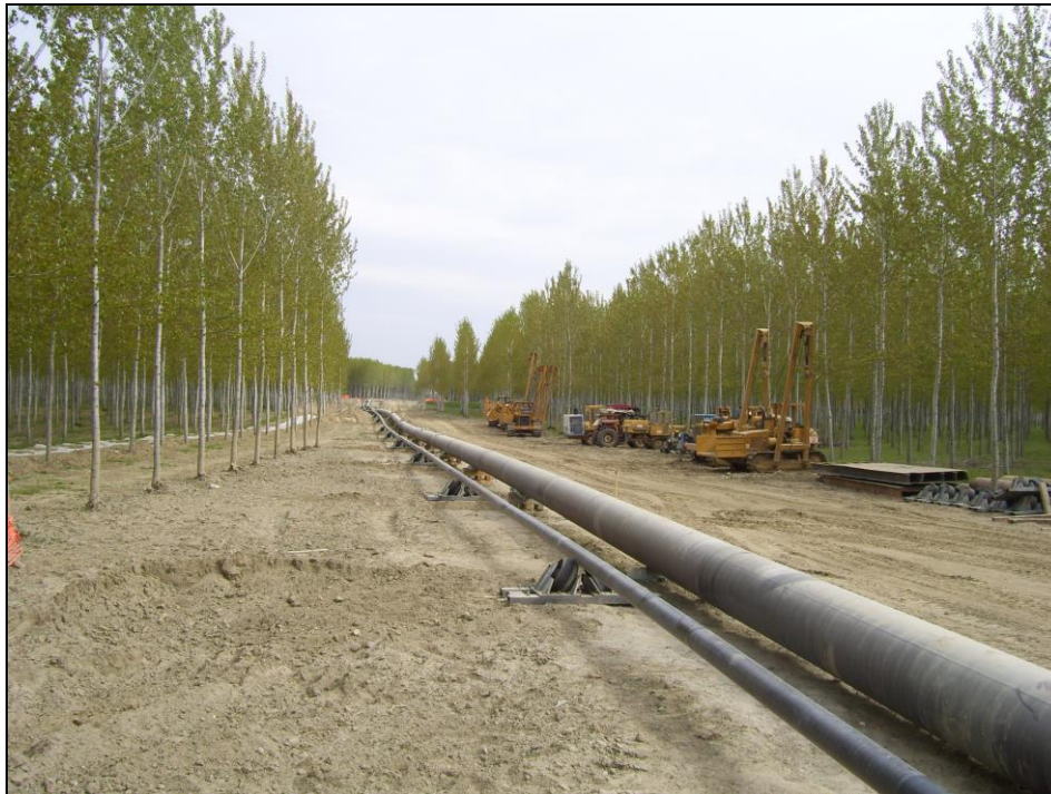
Fig.7.4/D: Attr.to F. Po con Met. DN30” – Colonna di varo preassemblata lungo l'area di passaggio
