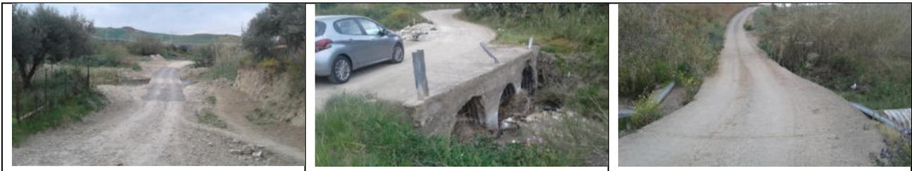
*Figura 2.5: Attraversamento idraulici di cantiere eventualmente da adeguare.*
